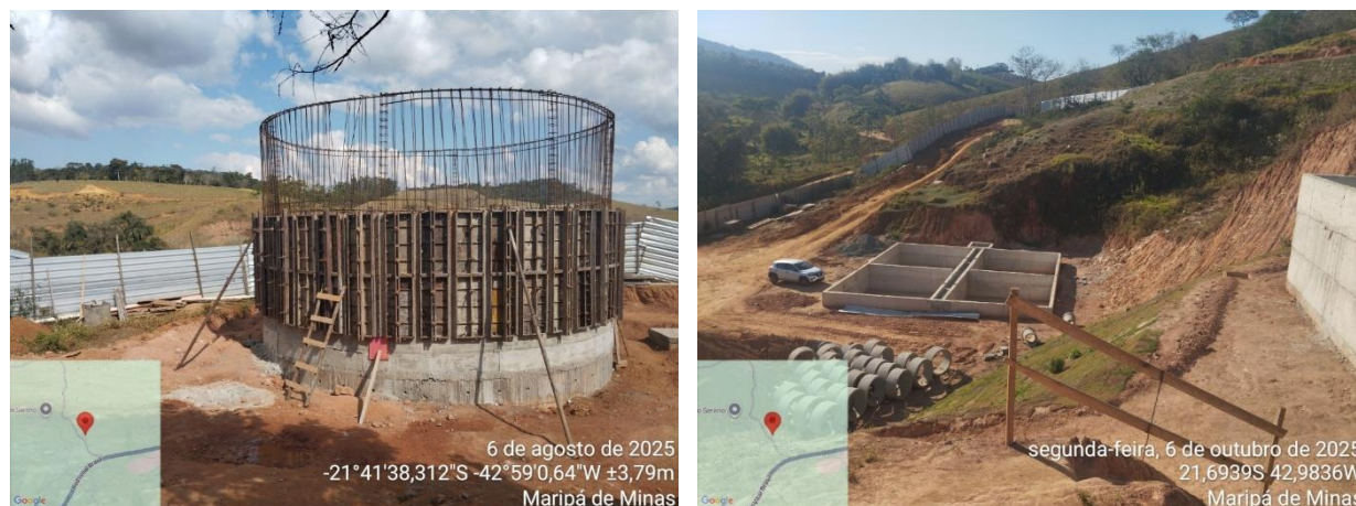
Figura 15. Obras iniciadas no local da ETE central – Maripá de Minas/MG.
