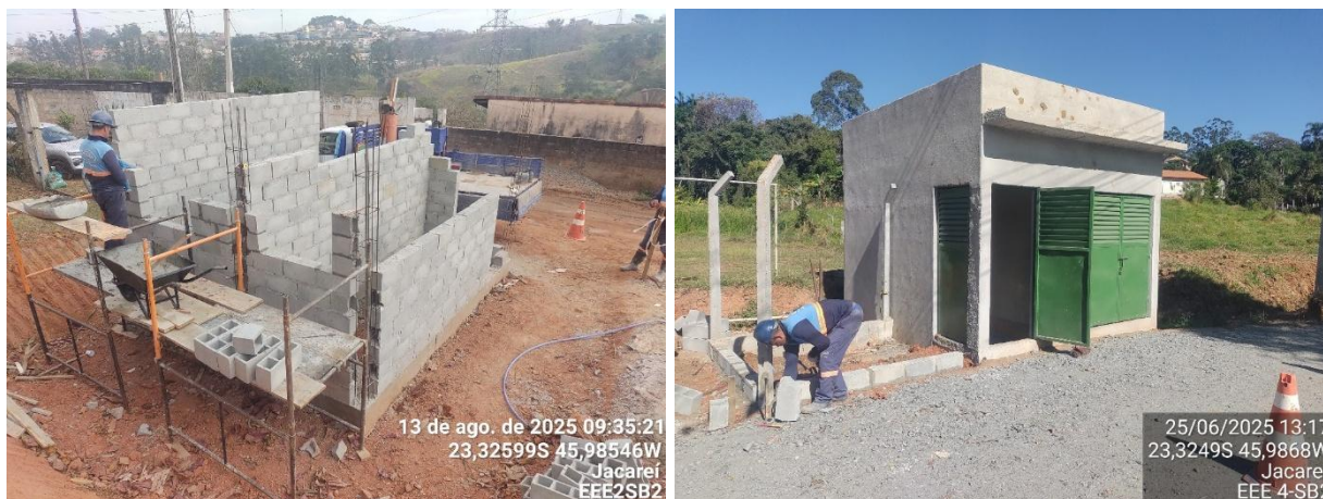
Figura 11. Obras em andamento no bairro Estância Porto Velho.
