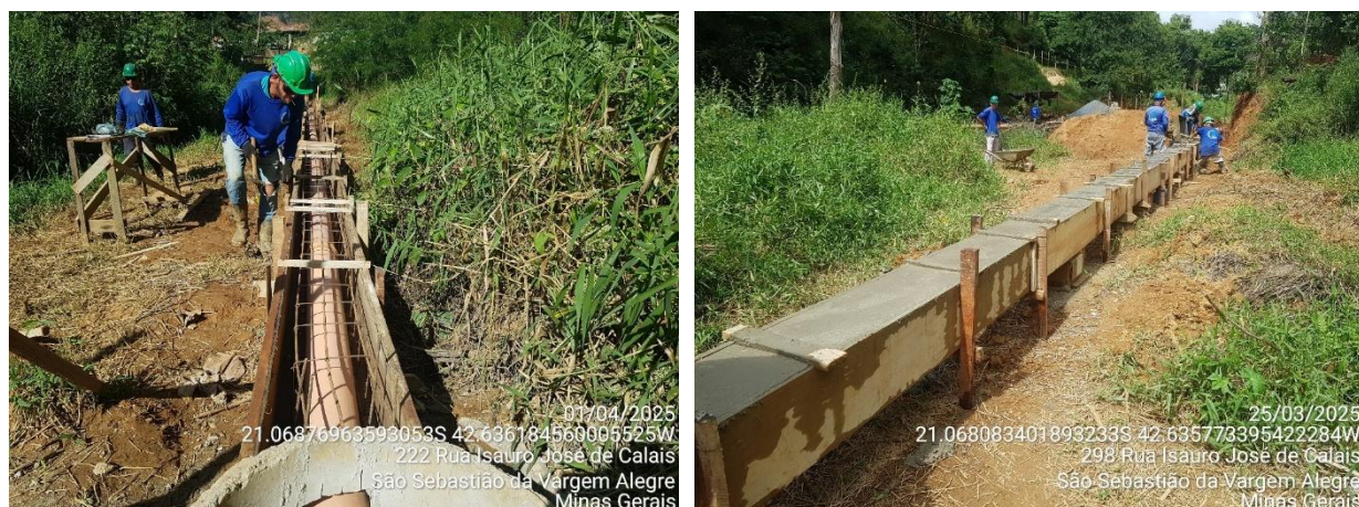
Figura 17. Obras em andamento em São Sebastião da Vargem Alegre.
