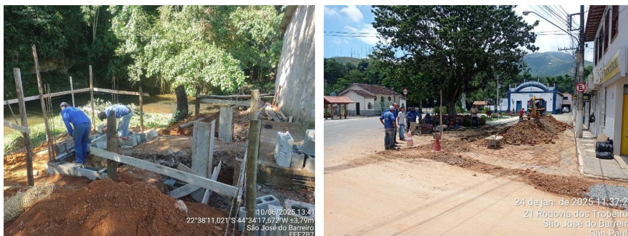
Figura 8. Avanço das obras em São José do Barreiro.
