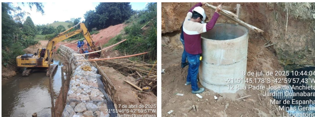
Figura 12. Obras em andamento em Mar de Espanha/MG.
