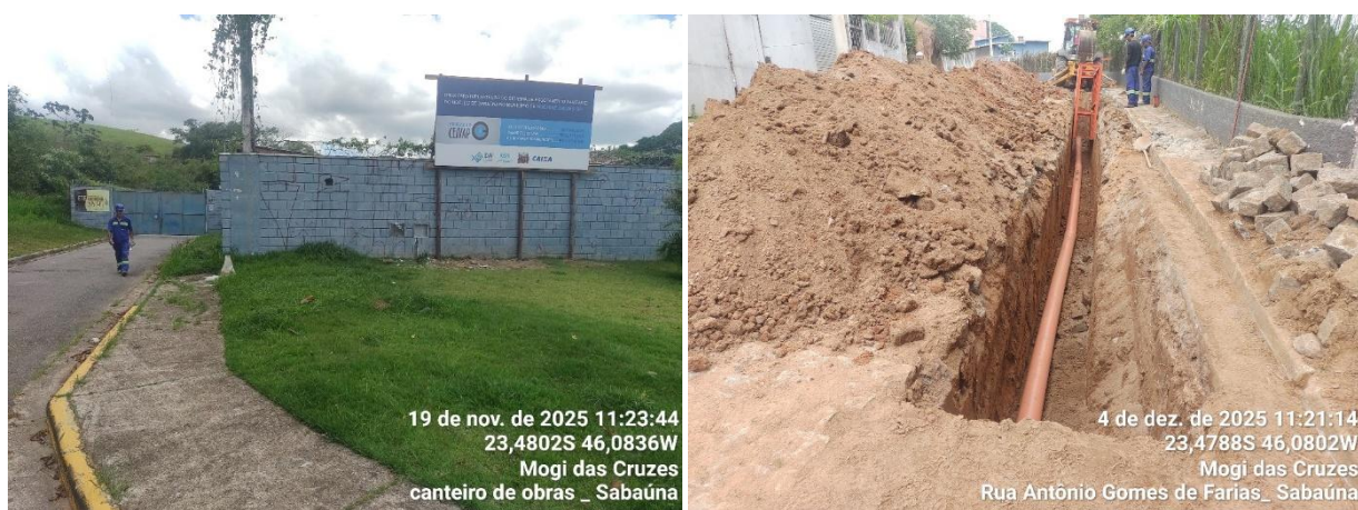
Figura 22. Obras em andamento em Sobral Pinto, em Astolfo Dutra.
