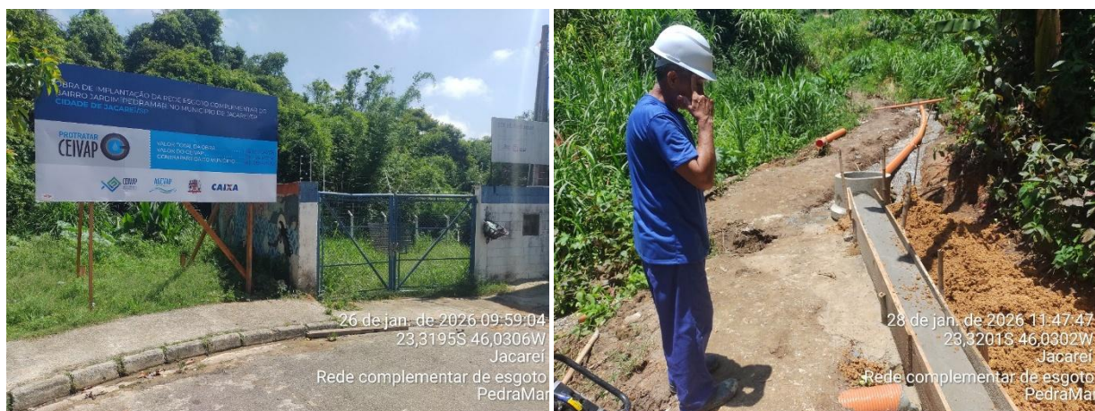
Figura 19. Obras em andamento em Rede Coletora do Jardim Pedramar, em Jacareí.
