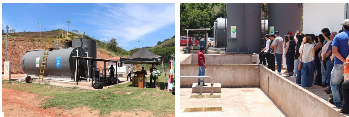
Figura 9. Obras concluídas da ETE em Olaria/.
