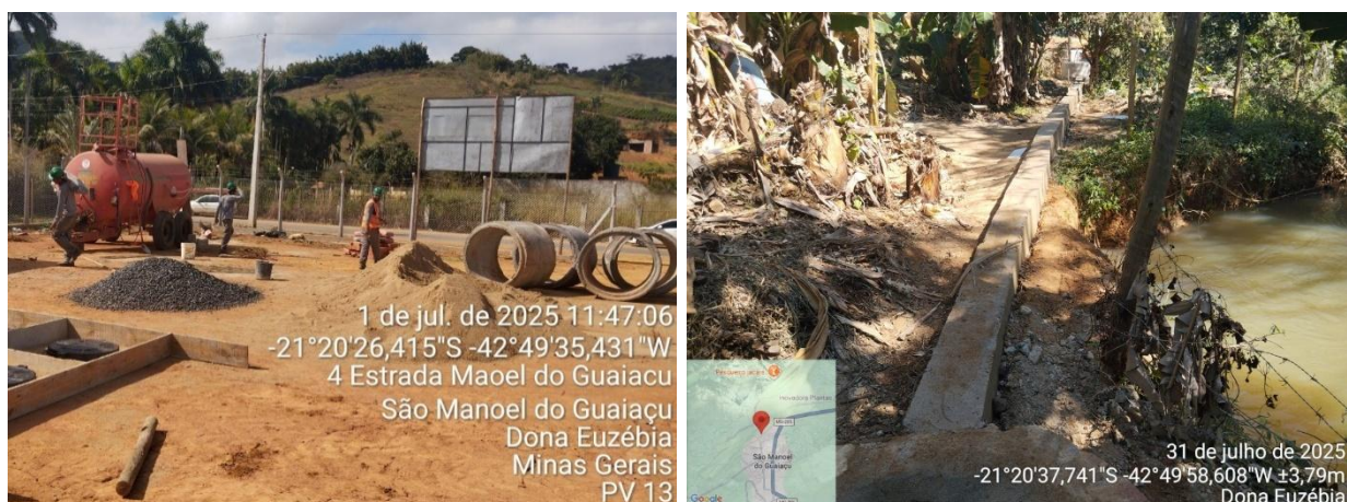
Figura 18. Obras em andamento em São Manoel do Guaiáçu, em Dona Euzébia.
