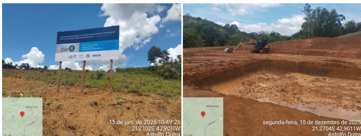
Figura 21. Obras em andamento em Sobral Pinto, em Astolfo Dutra.
