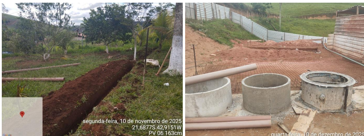
Figura 16. Obras em andamento no bairro Contendas – Maripá de Minas/MG.
