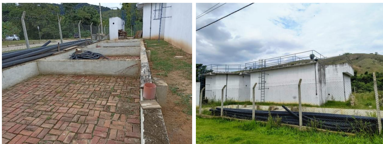
Figura 7. Avanço das obras na ETE Areias.
