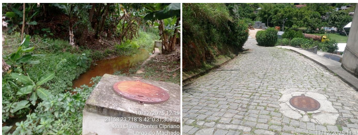
Figura 13. Obras em andamento em Santa Maria Madalena/RJ.
