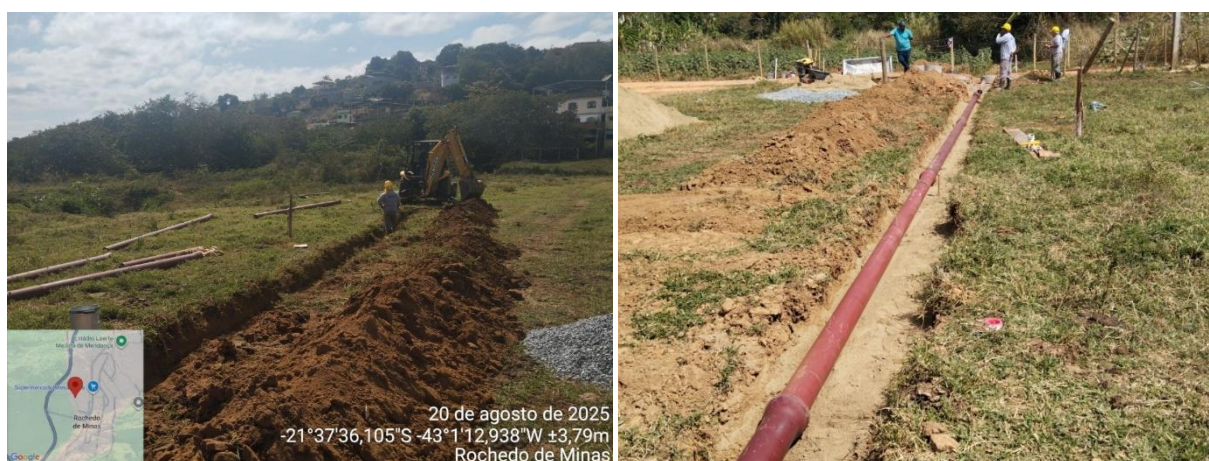
Figura 20. Obras em andamento em Rochedo de Minas.
