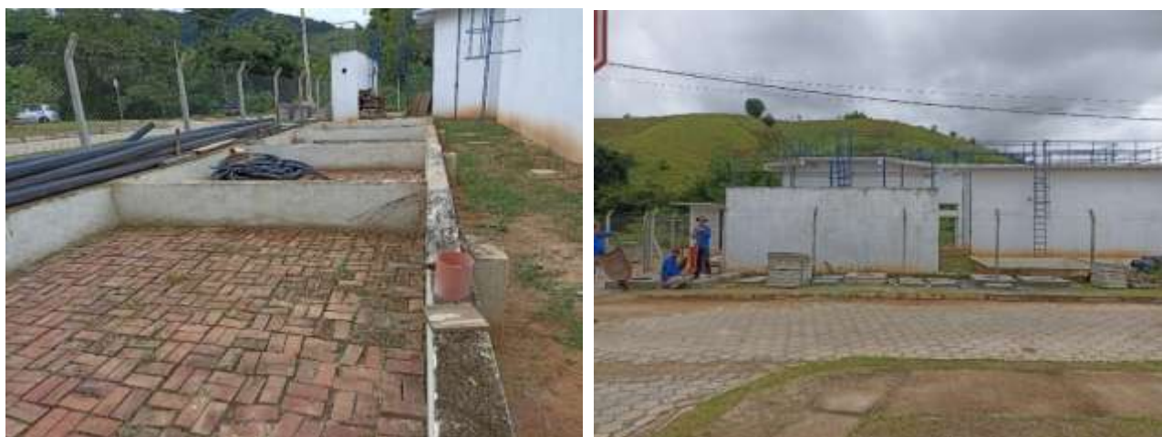
Figura 8. Avanço das obras na ETE Areias em abril de 2024.
