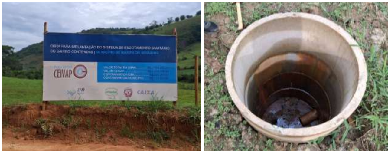
Figura 17. Obras em andamento no bairro Contendas – Maripá de Minas/MG, em dezembro de 2024.
