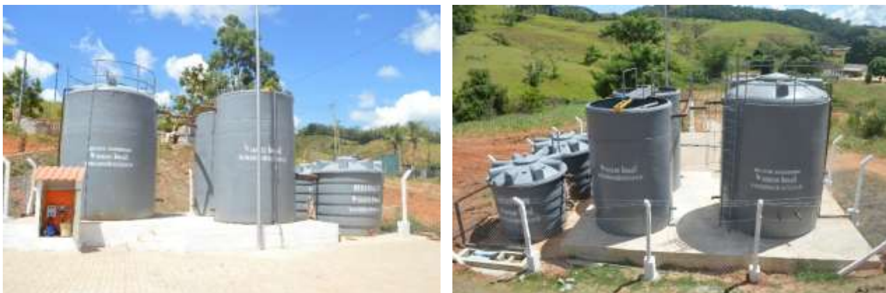
Figura 11. Obras concluídas da ETE em Maripá de Minas/MG – Pedra Branca, em agosto de 2024.
