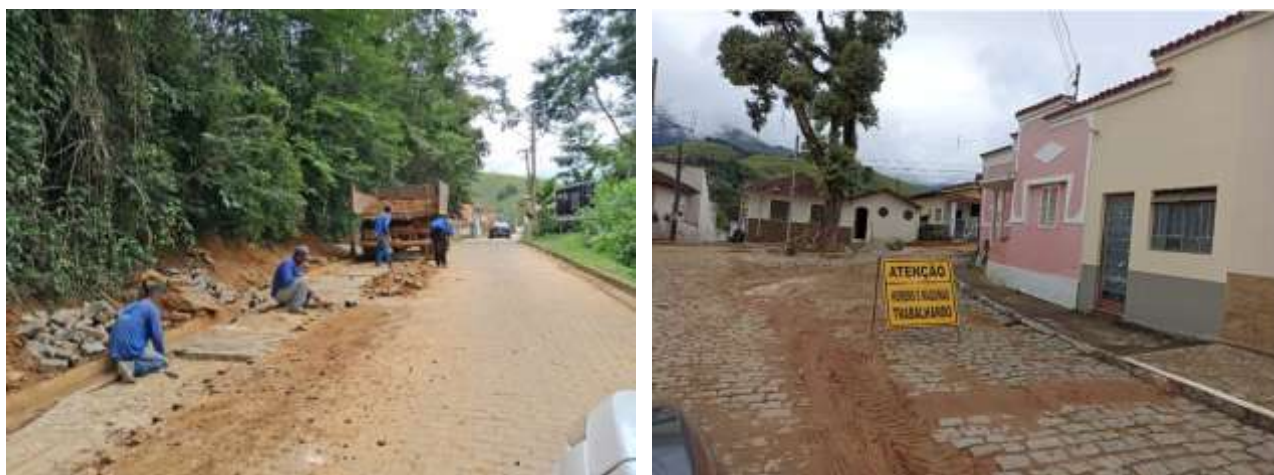
Figura 9. Avanço das obras em São José do Barreiro em abril de 2024.
