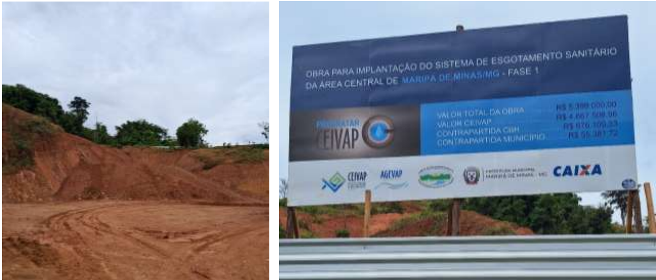
Figura 16. Obras iniciadas no local da ETE central – Maripá de Minas/MG, em dezembro de 2024.
