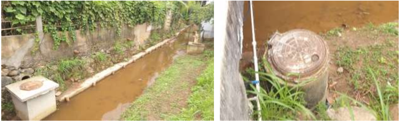
Figura 14. Obras em andamento em Santa Maria Madalena/RJ, em dezembro de 2024.
