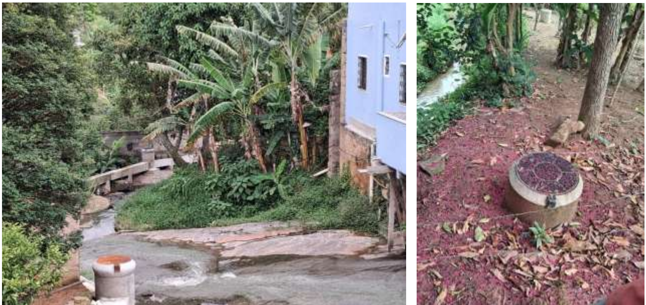
Figura 15. Obras em andamento em Santa Maria Madalena/RJ, em dezembro de 2024.
