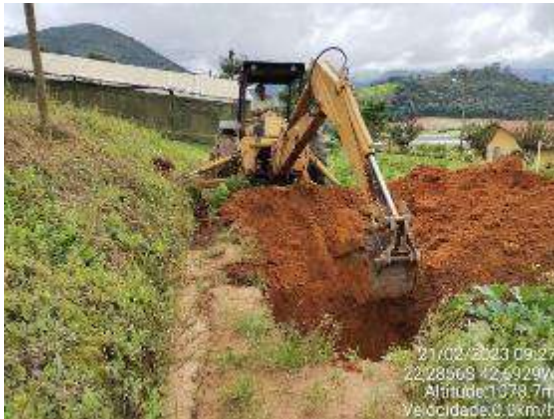
Figura 22. Obras de instalação de sistemas de tratamento de efluentes domésticos na microbacia de Barracão dos Mendes em Nova Friburgo/RJ.
