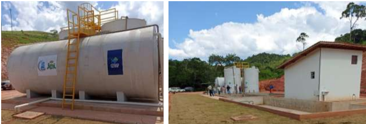
Figura 10. Obras concluídas da ETE em Olaria/MG, em dezembro de 2024.
