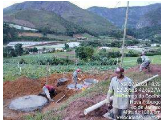
Figura 22. Obras de instalação de sistemas de tratamento de efluentes domésticos na microbacia de Barracão dos Mendes em Nova Friburgo/RJ.
