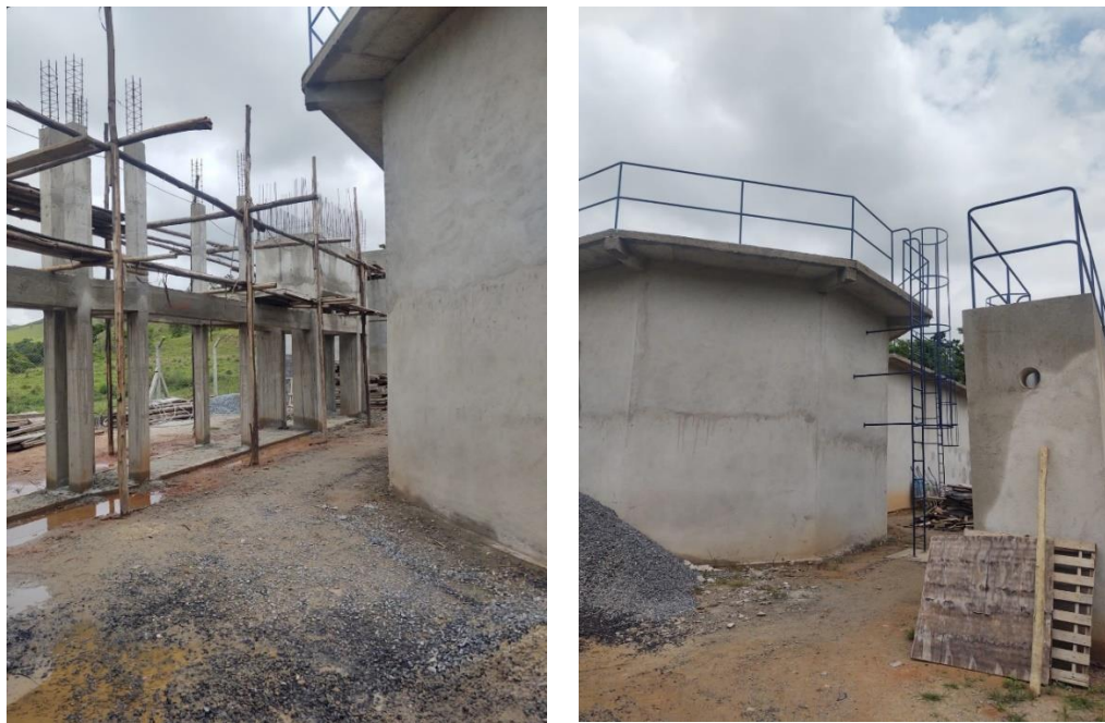
Figura 15 – Avanço das obras na ETE Areias em março de 2023.
