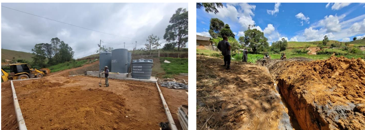
Figura 23 – Fotos da obra do sistema de esgotamento sanitário do Bairro Darcy José da Costa (Pedra Branca), no município de município de Maripá de Minas/MG, em outubro de 2023.
