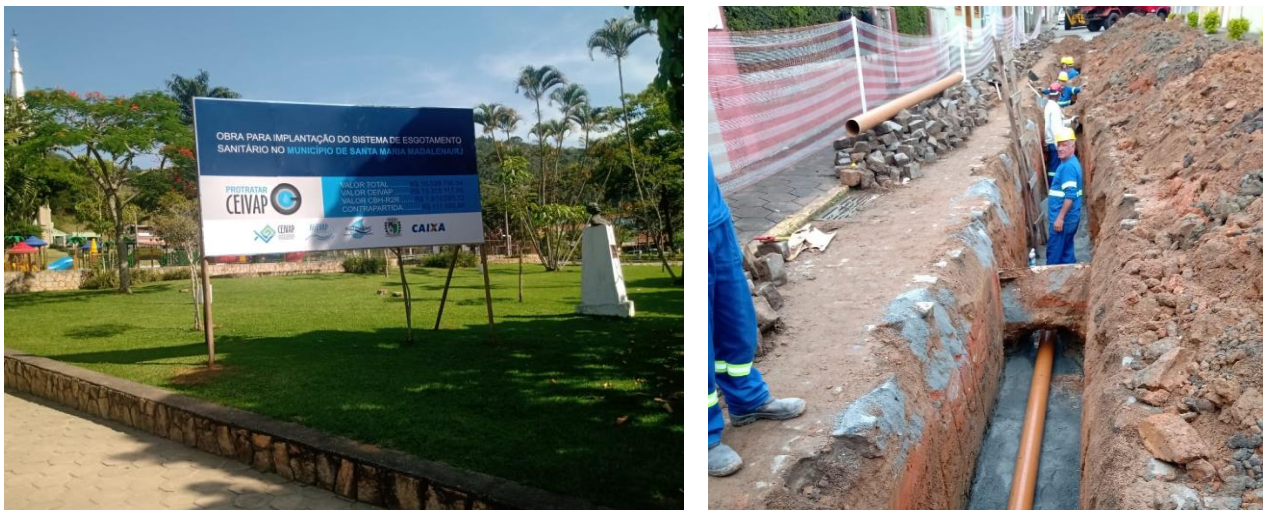
Figura 21 – Fotos da obra do sistema de esgotamento sanitário dos Bairros Centro e Itaporanga no município de Santa Maria Madalena, em outubro de 2023.
