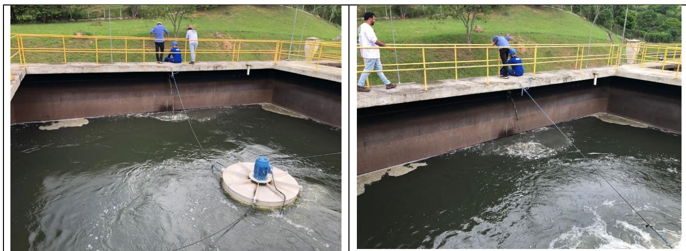
Figura 14 – Imagens do 4º Tanque concluído na ETE Bandeira Branca - Jacareí, em operação em 31/10/23
