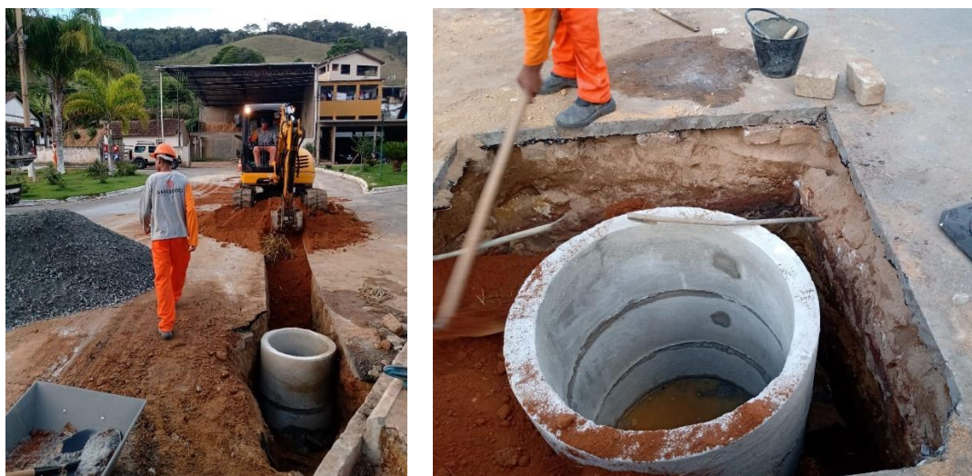
Figura 22 – Fotos da obra de rede coletora de esgotos contribuintes à ETE Largo do Machado Arranchadouro município de Santa Maria Madalena, em outubro de 2023.
