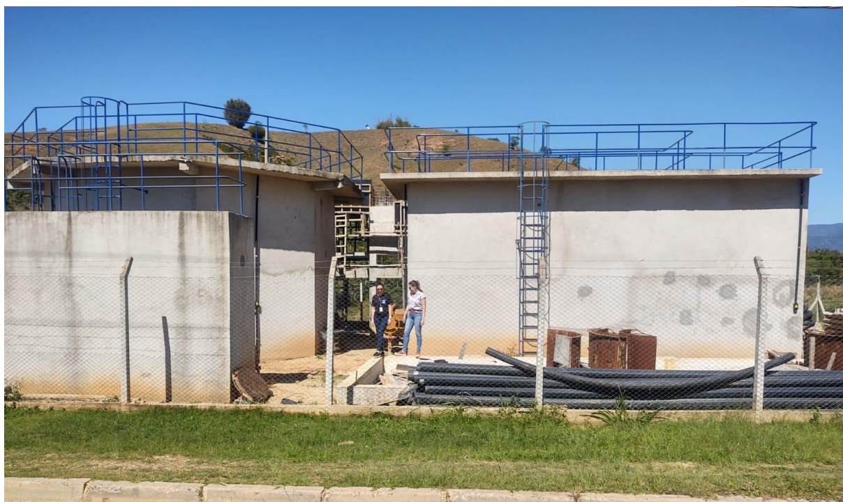
Figura 16 – Avanço das obras na ETE Areias em setembro de 2023.
