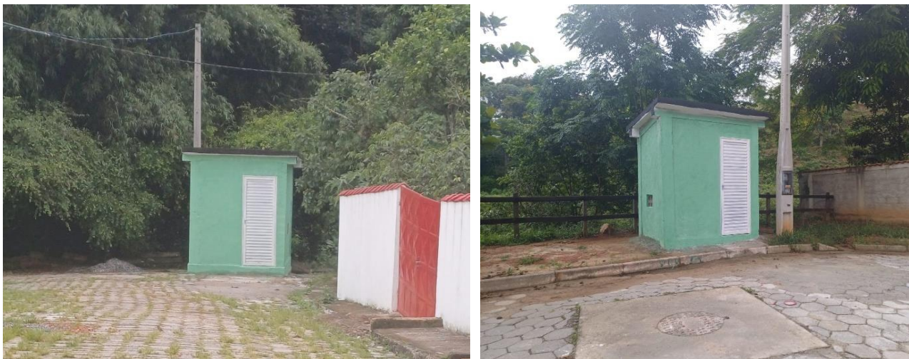
Figura 17 – Abrigos dos geradores de emergência das estações elevatórias de esgoto já executados em Areias, outubro de 2023.
