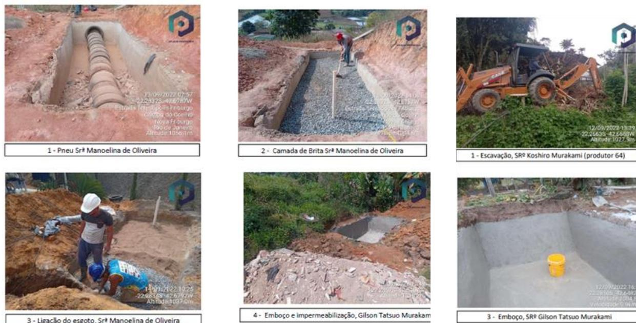
Figura 15 – Obras de instalação de sistemas de tratamento de efluentes domésticos na microbacia de Barracão dos Mendes em Nova Friburgo/RJ.
