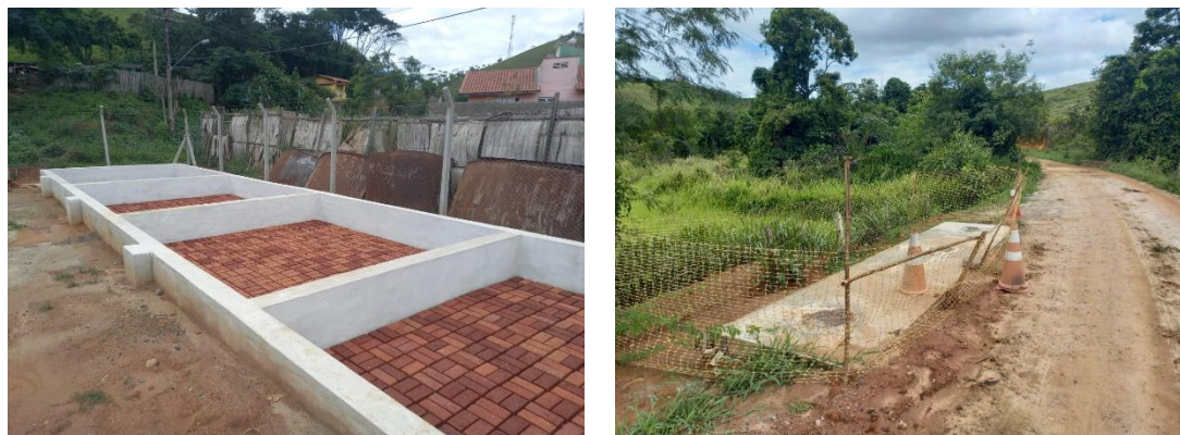
Figura 23 - Imagens das obras em Areias em dezembro de 2021
