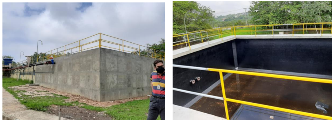
Figura 15 - Imagens das obras em Jacareí, em dezembro de 2020.
