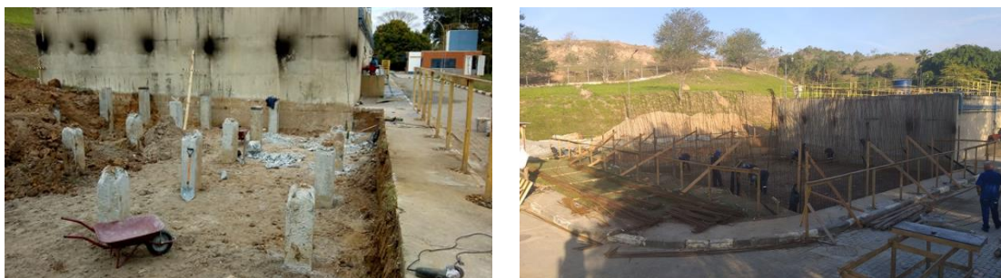
Figura 13 - Imagens do início das obras em Jacareí, em junho de 2020
