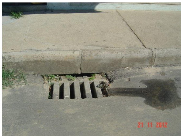
Figura 22 – Boca de lobo na localidade de Massambará
