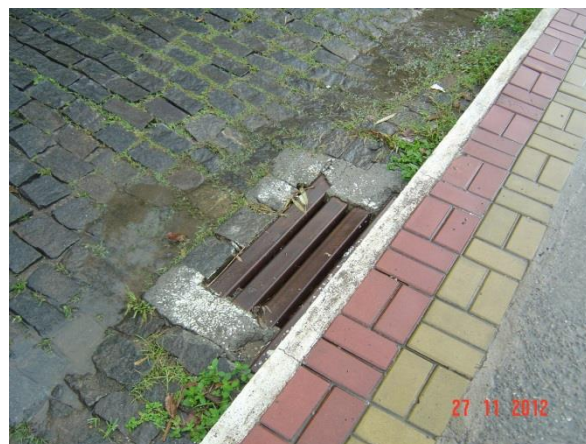
Figura 23 – Boca de lobo localizada no bairro Centro
