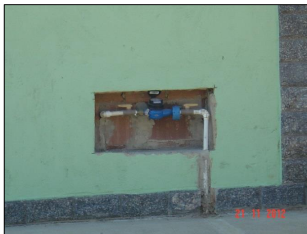
Figura 16 – Ligação com hidrômetro - Massambará
