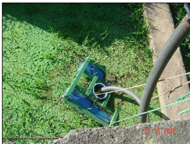
Figura 9 – Poço tubular de Andrade Costa
