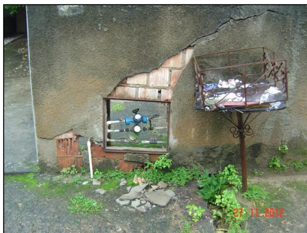
Figura 15 – Ligação com hidrômetro - Centro
