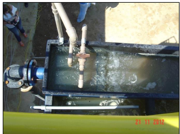
Figura 14 – Ponto de aplicação de coagulante e misturador - São Sebastião dos Ferreiros
