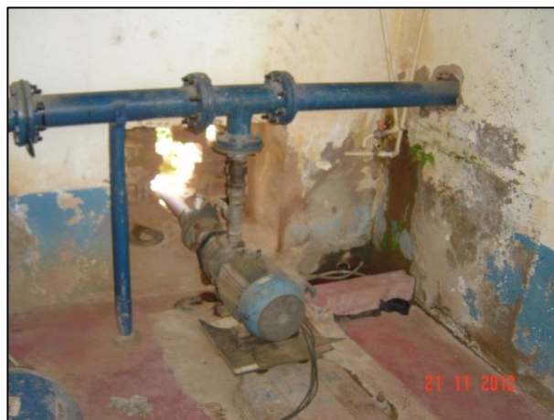
Figura 12 – Vista interna da EEAB de Andrade Pinto
