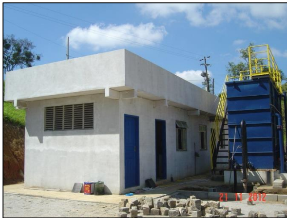
Figura 13 – Vista da ETA São Sebastião dos Ferreiros
