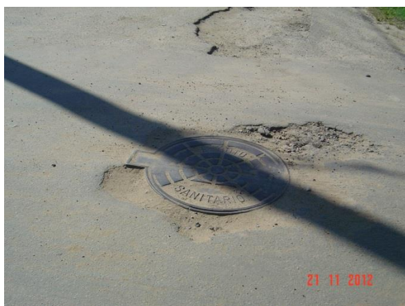
Figura 20 – Poço de Visita – Bairro Massambará
