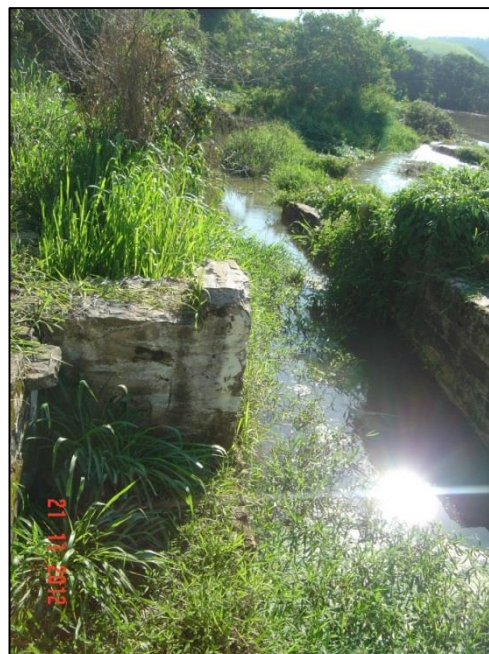
Figura 10 – Rio Paraíba do Sul nas proximidades da captação
