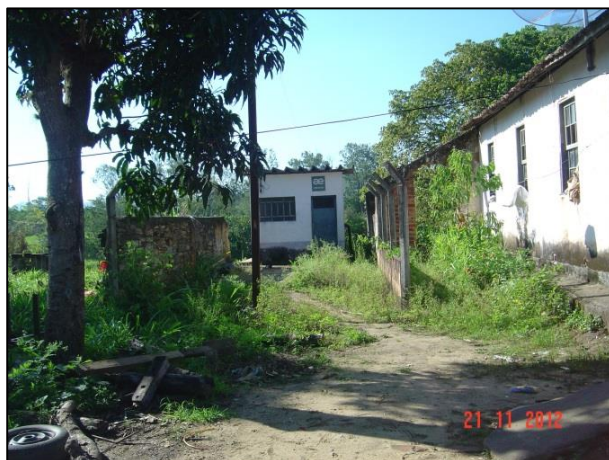
Figura 11 – Vista da captação e EEAB de Andrade Pinto
