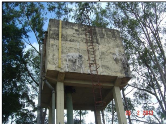
Figura 26 – Reservatório junto a ETA Valença.
