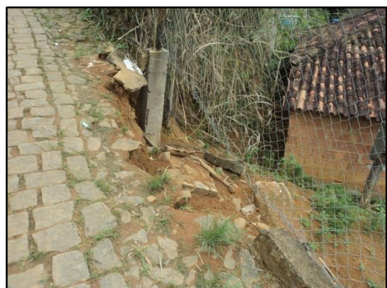
Figura 71 – Área de risco localizada no distrito de Santa Isabel do Rio Preto.
