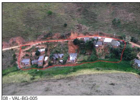
Figura 74 – Área de risco Estr Fazenda do Caixão na Estr. Júlio Furtado.
