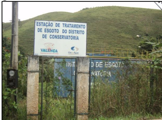
Figura 48 – Vista 1 da ETE Conservatória.
