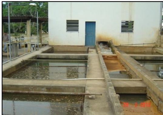
Figura 15 – Vista da ETA Centro.
