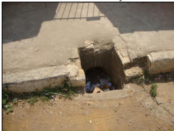
Figura 62 – Boca de lobo em péssimo estado de conservação 1.
