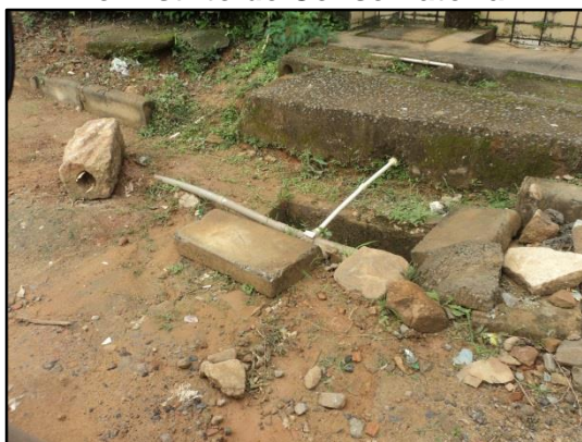
Figura 34 – Tubulação de água exposta no Distrito de Conservatória.
