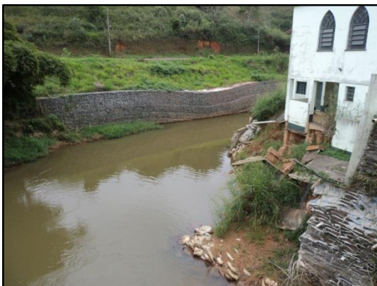
Figura 70 – Área de risco na Ponte Leite Pinto localizada no distrito de Santa Isabel do Rio Preto.
