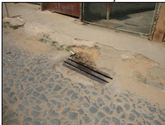
Figura 64 – Boca de lobo em péssimo estado de conservação 3.
