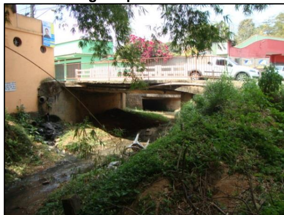
Figura 59 – Córrego que recebe águas pluviais.
