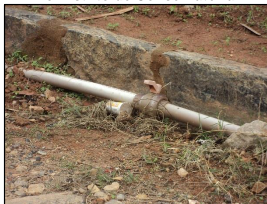
Figura 35 – Tubulação de água exposta no Distrito de Conservatória.
