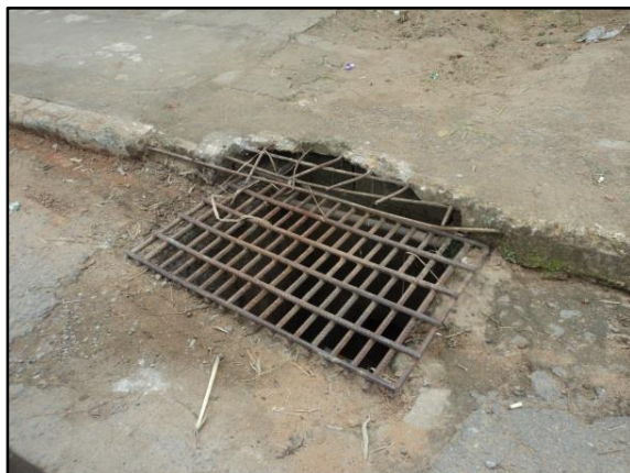
Figura 66 – Boca de lobo no Distrito de Santa Isabel do Rio Preto.
