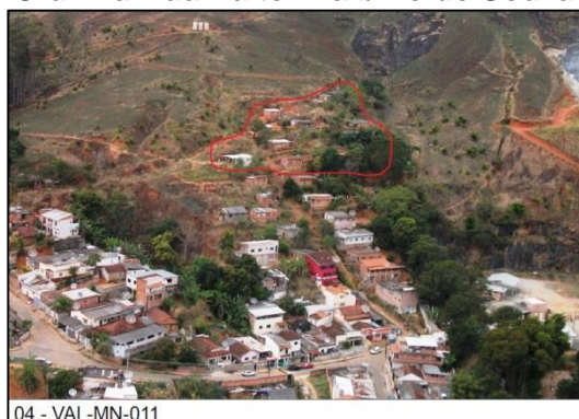
Figura 73 – Área de risco bairro Sta. Cruz na Rua Valter Balbino de Souza.
