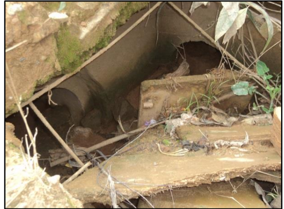
Figura 69 – Boca de Lobo em péssimo estado no distrito de Conservatória.
