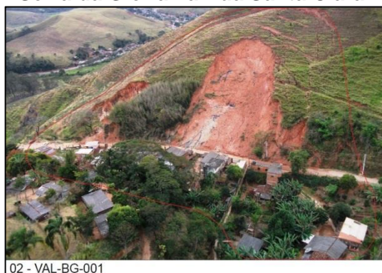
Figura 72 – Área de risco no bairro Serra da Glória na Rua Santa Clara.
