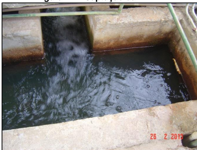
Figura 12 – Captação da EEAB.
