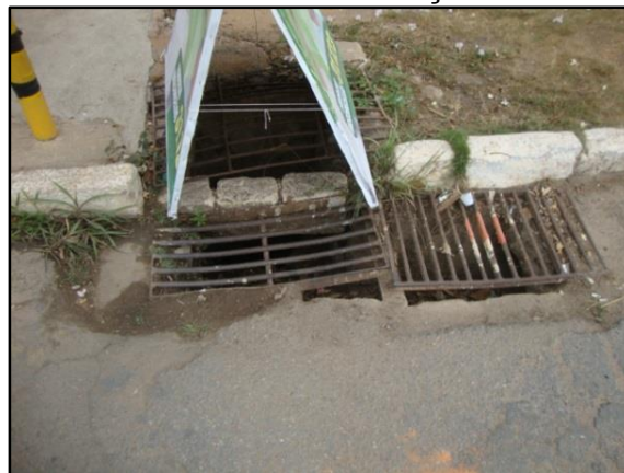
Figura 63 – Boca de lobo em péssimo estado de conservação 2.
