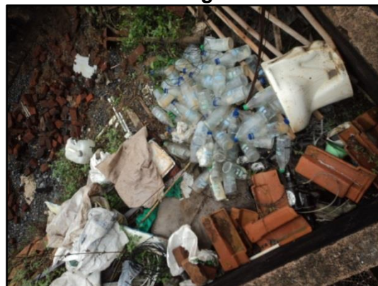
Figura 53 – Depósito localizado na ETE Pentagna.
