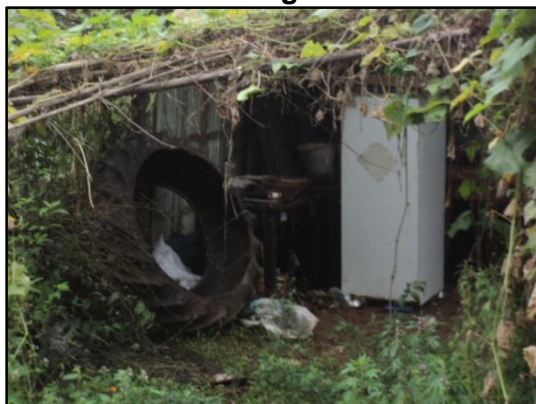
Figura 52 – Depósito localizado na ETE Pentagna.
