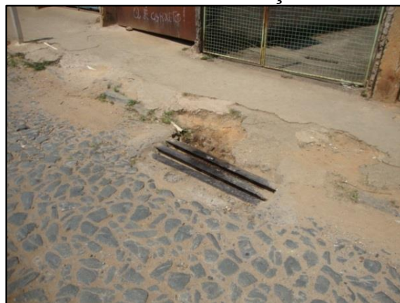
Figura 65 – Boca de lobo em péssimo estado de conservação 4.
