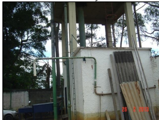
Figura 27 – Reservatório junto a ETA Valença.
