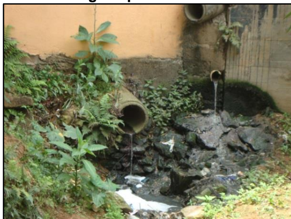
Figura 58 – Córrego que recebe águas pluviais.
