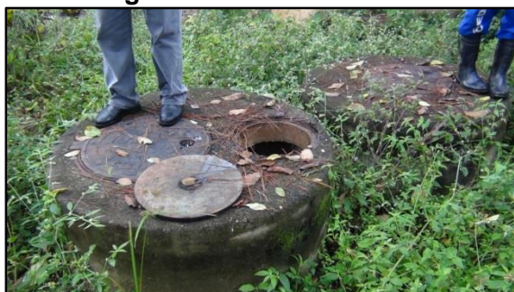
Figura 46 – EEE localizada no distrito de Pentagna na Rua Euclides Alves.
