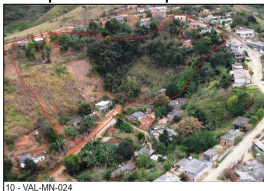
Figura 75 – Área de risco no distrito de Juparanã na R. Duque de Caxias.
