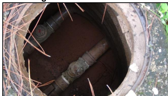
Figura 47 – EEE localizada no distrito de Pentagna na Rua Euclides Alves.
