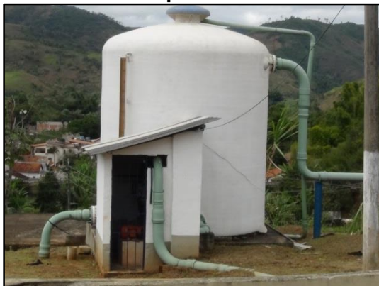
Figura 22 – Vista 1 da ETA Barão de Juparanã.
