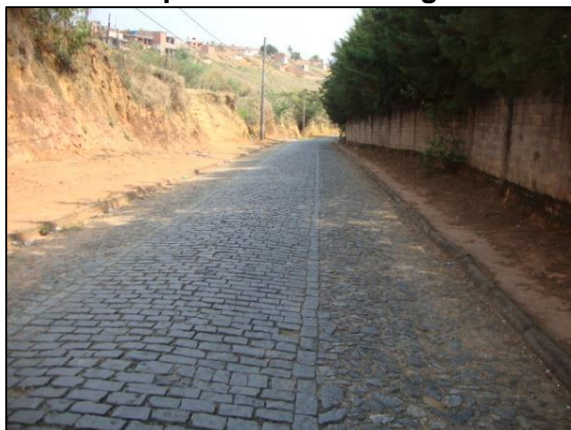
Figura 60 – Rua com carregamento de solo pela falta de drenagem.
