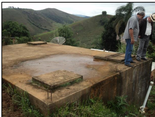
Figura 28 – Reservatório mais alto no Distrito de Santa Isabel do Rio Preto.
