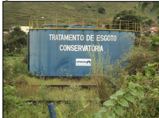
Figura 49 – Vista 2 da ETE Conservatória.
