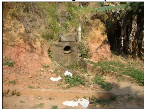
Figura 61 – Carregamento de solo por falta de drenagem adequada.
