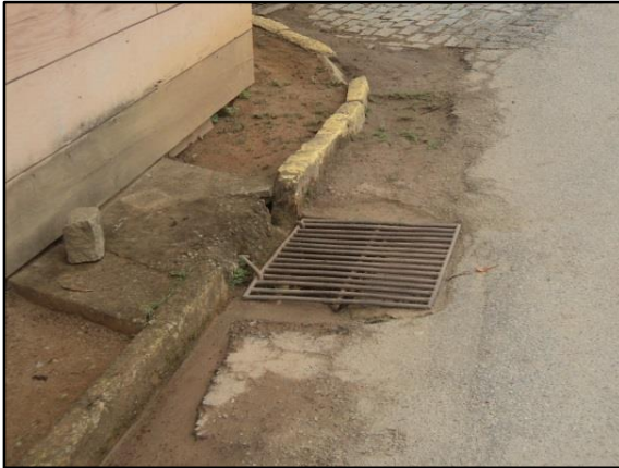
Figura 68 – Boca de lobo no distrito de Conservatória.
