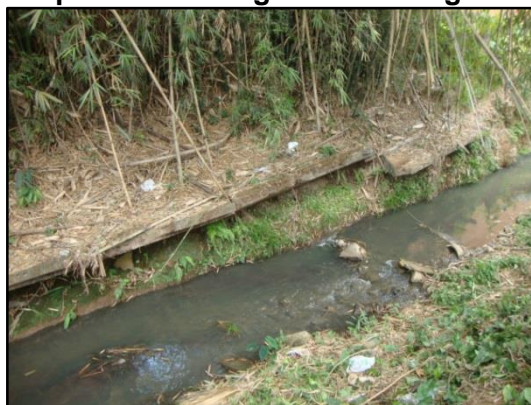
Figura 55 – Saída de rede de esgoto e pluvial na margem do Córrego.
