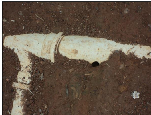
Figura 37 – Rede coletora exposta no distrito de Santa Isabel do Rio Preto.
