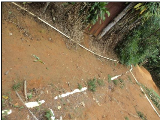
Figura 36 – Rede coletora exposta no distrito de Santa Isabel do Rio Preto.
