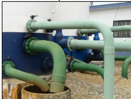
Figura 23 – Vista 2 da ETA Barão de Juparanã.
