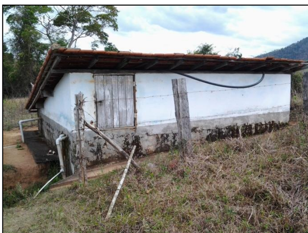
Figura 23 – Reservatório R13 - vista 1
