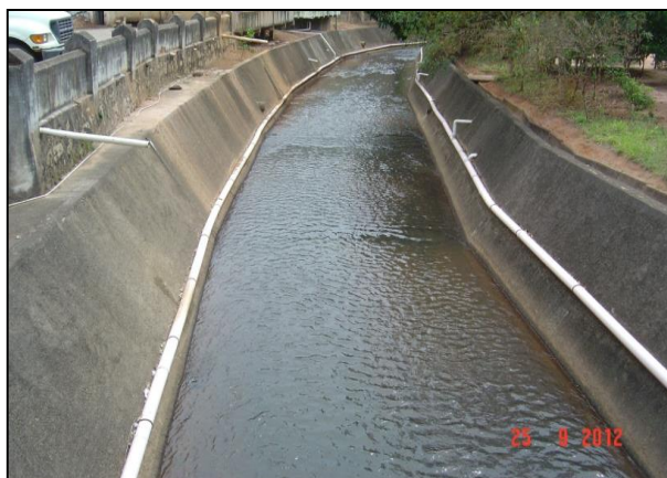
Figura 33 – Canalização predial dentro do curso do rio
