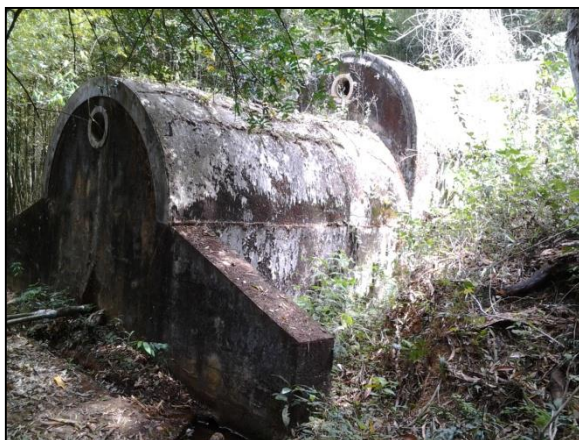
Figura 17 – Reservatório R04 - vista 1
