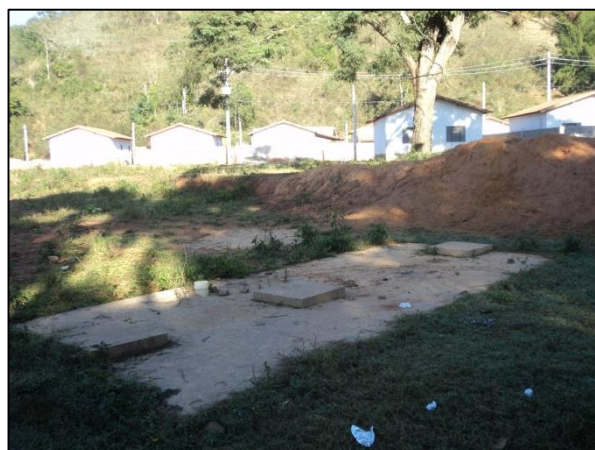
Figura 41 – Fossa séptica Abarracamento 2 - vista 2
