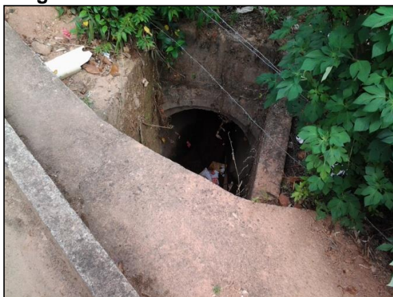
Figura 48 – Amarrete tubular obstruído
