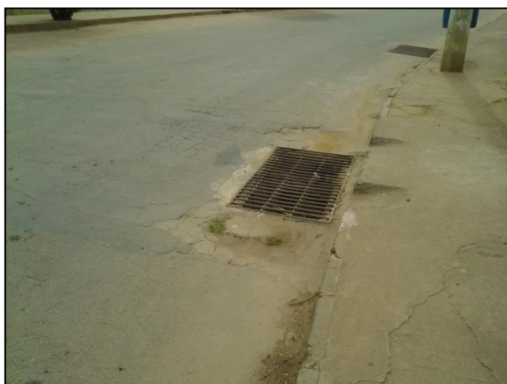
Figura 52 – Vista de boca de lobo
