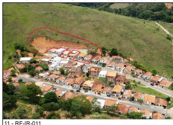
Figura 59 – Área de risco no bairro José Dutra Navarro na R. Paulo Valente
