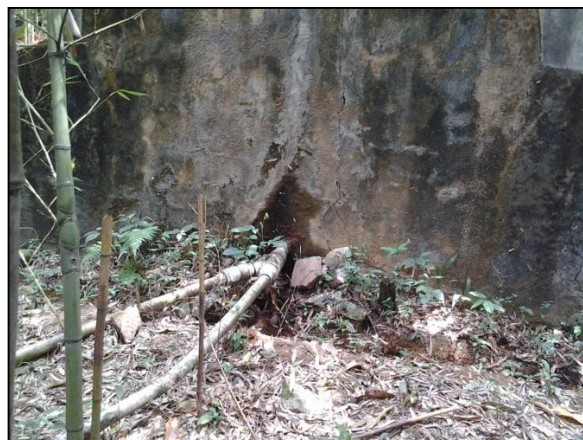
Figura 18 – Reservatório R04 - vista 2
