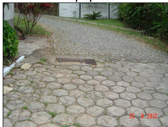
Figura 53 – Boca de lobo em local inapropriado
