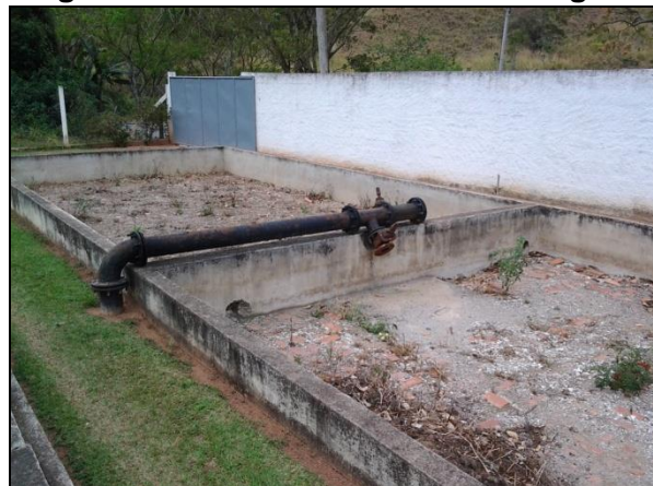
Figura 37 – Vista dos leitos de secagem
