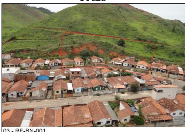
Figura 56 – Área de risco no bairro Manuel Duarte na R. Antônio Dantas de Souza
