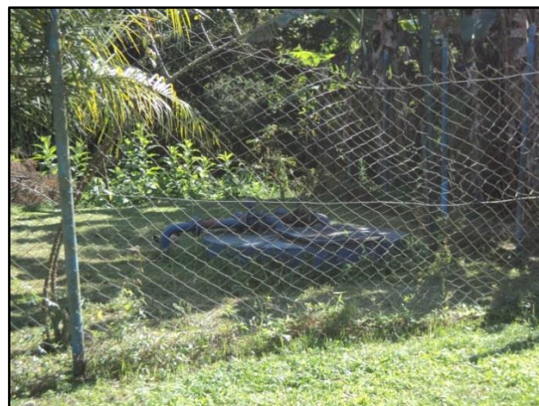
Figura 68 – Vista da ETE Fumaça
