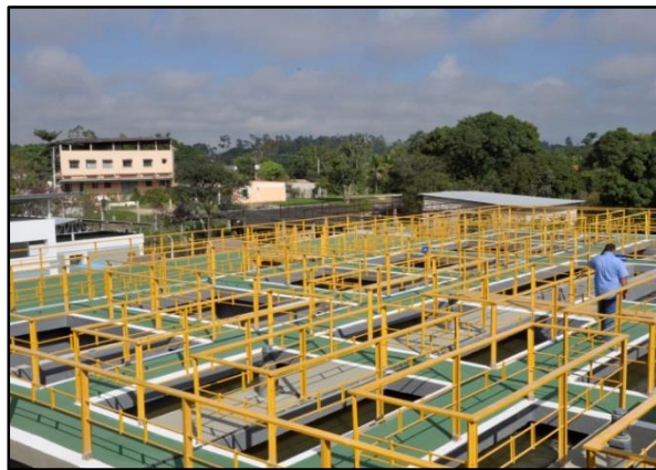
Figura 10 – Novo módulo da ETA Alegria
