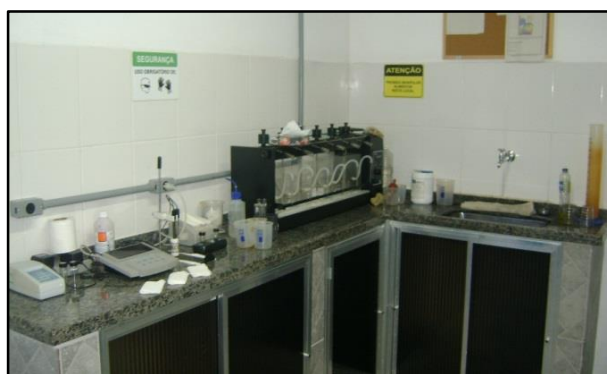
Figura 25 – Vista 01 - ETA São Caetano
