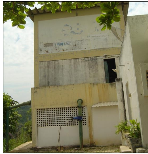
Figura 24 - Vista da ETA Avelar 2
