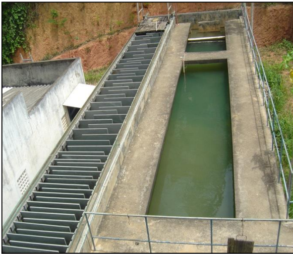
Figura 23 - Vista da ETA Avelar 1
