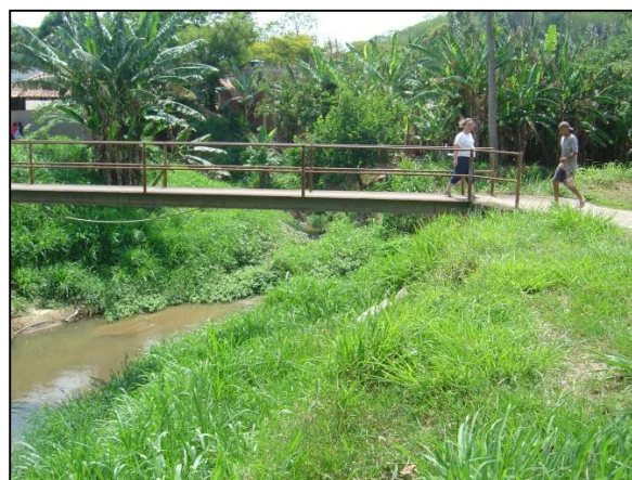
Figura 35 – Rio Ubá, área que é sujeita a inundações em períodos chuvosos
