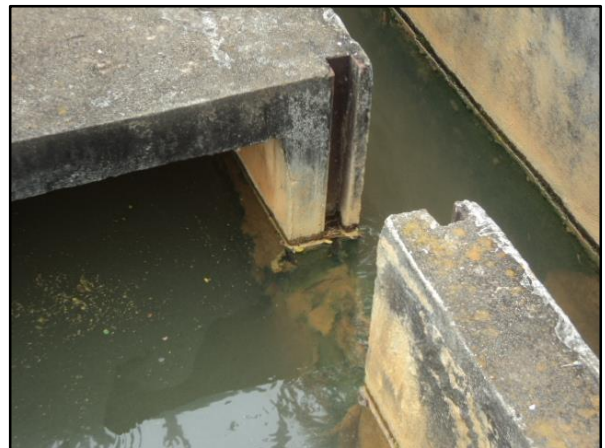
Figura 18 – Tanque de floculação
