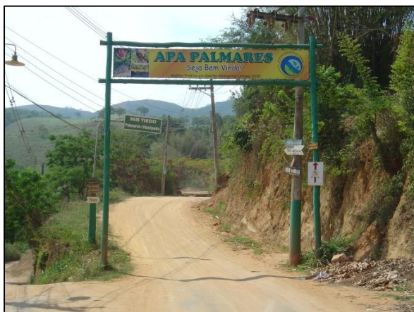
Figura 36 – Rua sem asfaltamento e sistema de drenagem
