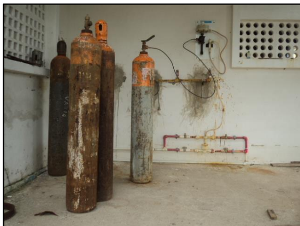
Figura 21 – Cilindros de cloro
