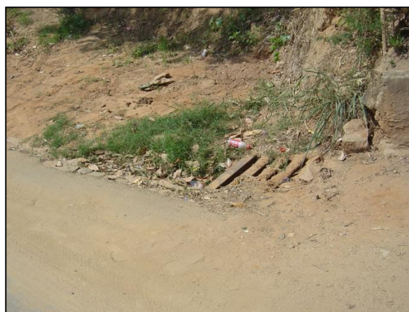
Figura 39 – Caixa de captação obstruída com terra e lixo
