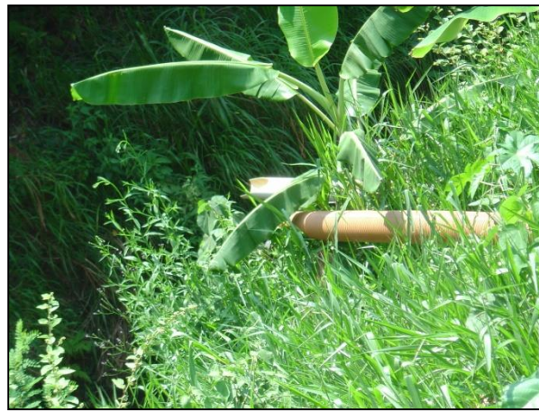
Figura 33 – Saída de esgoto in natura da ETE desativada no Rio Ubá
