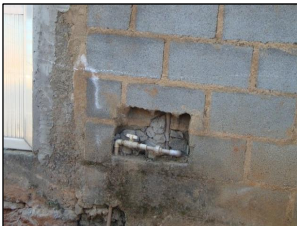
Figura 19 – Ligação com pena d'água
