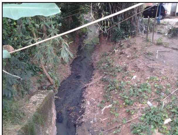
Figura 29 – Córrego que recebe águas pluviais
