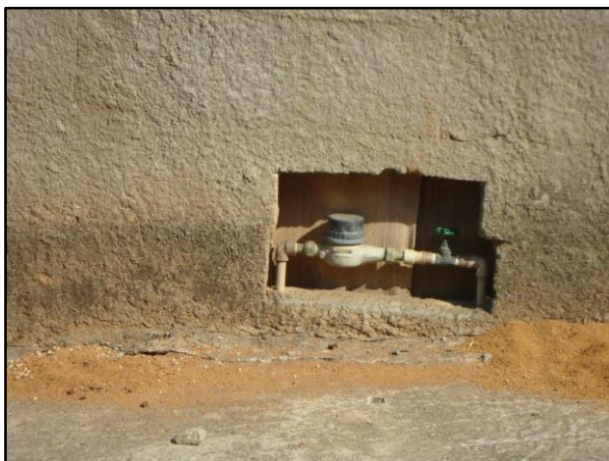
Figura 21 – Ligação com hidrômetro
