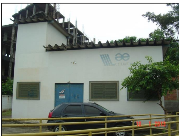
Figura 12 – Vista do abrigo da EEAB
