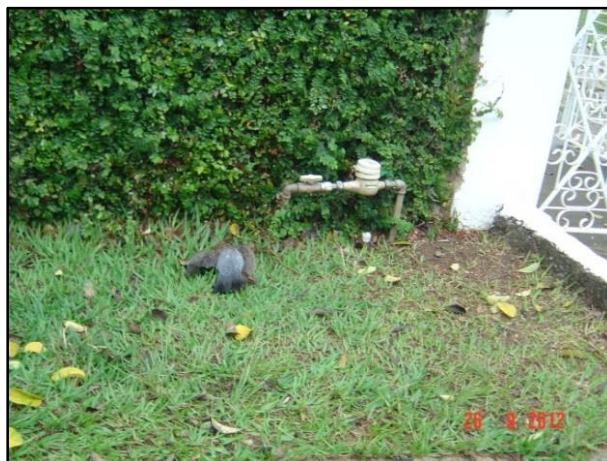
Figura 22 – Ligação com hidrômetro
