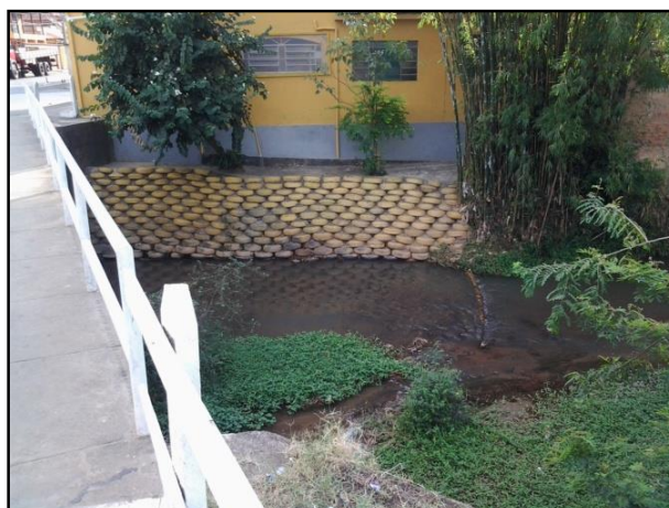
Figura 31 – Contenção de paliçada de pneus
