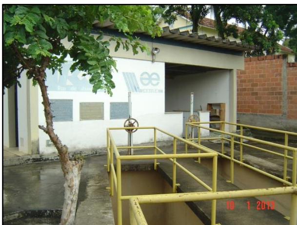
Figura 10 – Estação Elevatória de Água Bruta
