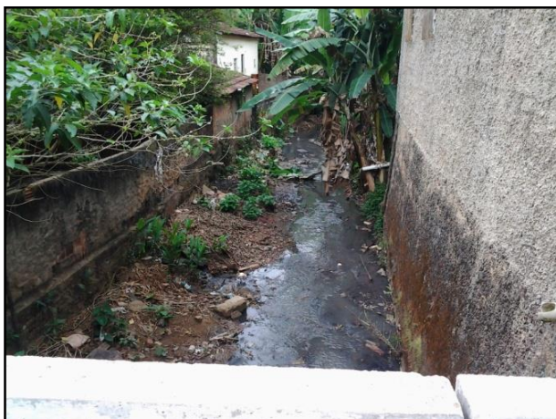
Figura 28 – Córrego que recebe águas pluviais
