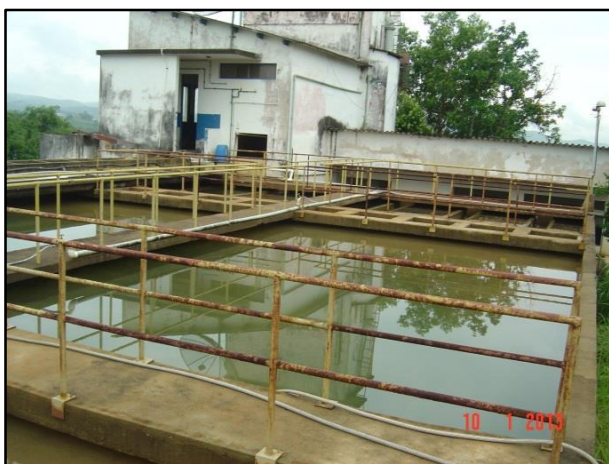
Figura 14 – Vista da ETA Centro
