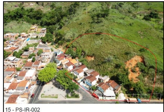
Figura 39 - Área de risco no bairro Liberdade na R. Durvalino Francisco de Oliveira
