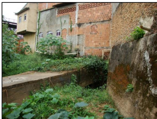
Figura 27 - Saída de rede de esgoto e pluvial na margem do Rio Paraíba do Sul
