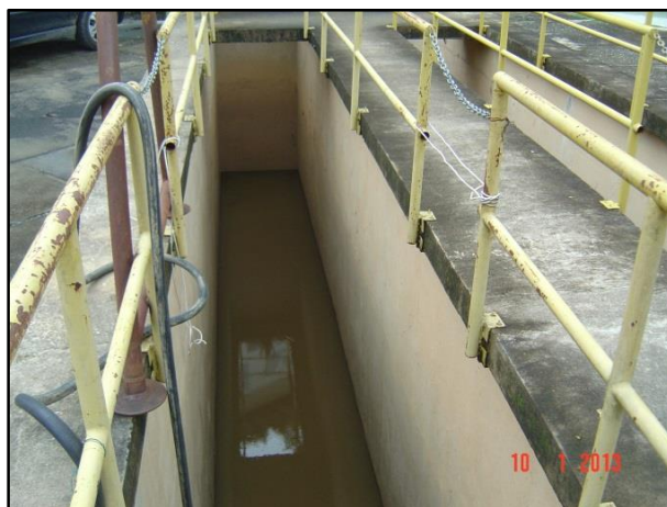
Figura 11 – Captação da EEAB
