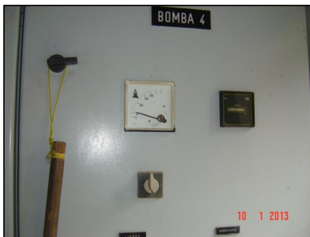
Figura 13 – Painel de forçada EEAB
