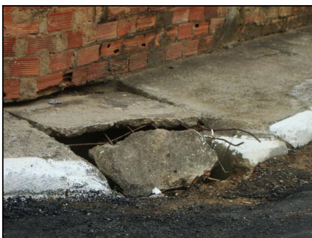
Figura 32 – Boca de lobo em péssimo estado de conservação 1
