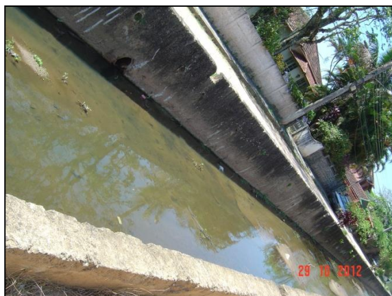
Figura 32 – Córrego do Sacco
