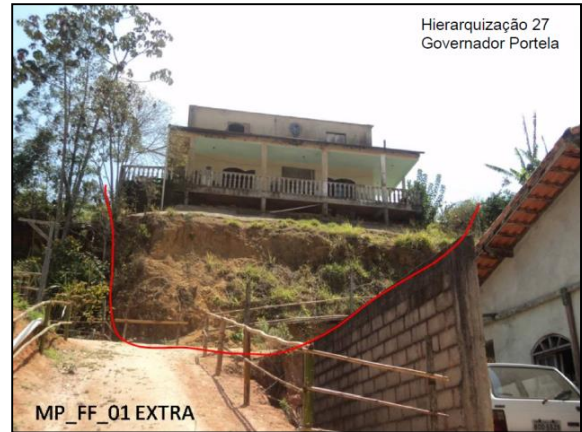
Figura 39 – Área de risco no bairro Governador Portela
