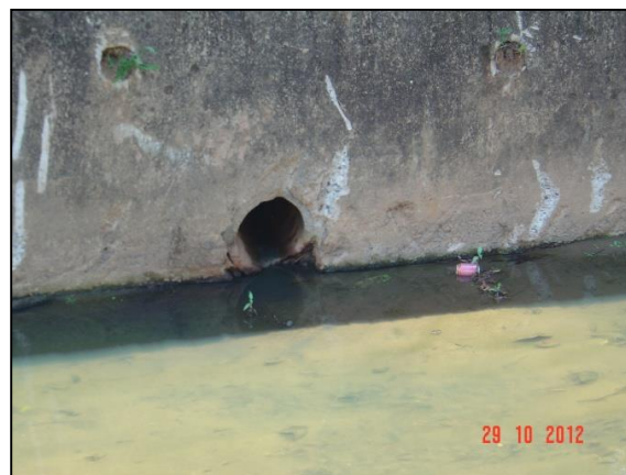
Figura 33 – Córrego do Sacco
