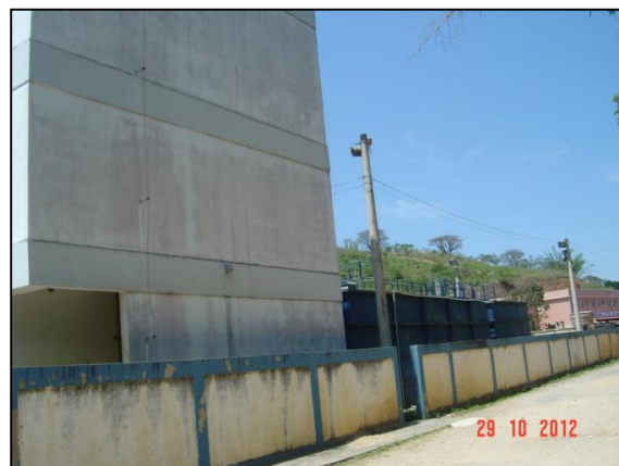
Figura 14 – Vista da ETA Fragoso
