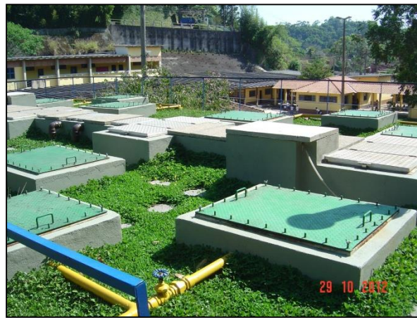
Figura 31 – Vista da ETE Javary 2
