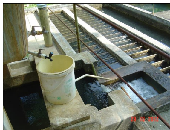
Figura 16 – Vista da ETA Conrado
