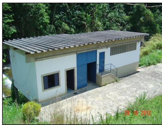
Figura 12 – Estação elevatória de água bruta
