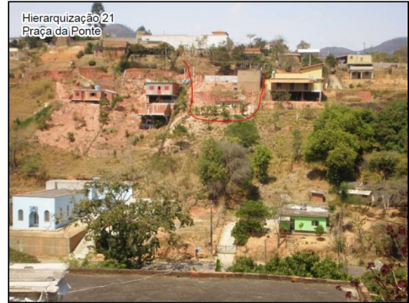
Figura 37 – Área de risco no bairro Praça da Ponte
