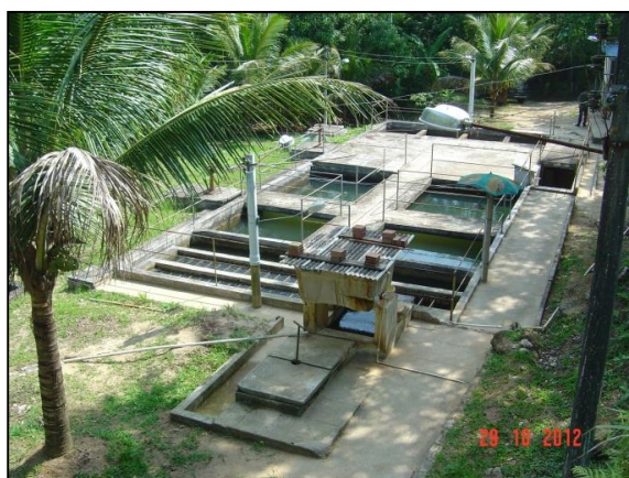
Figura 15 – Vista da ETA Conrado
