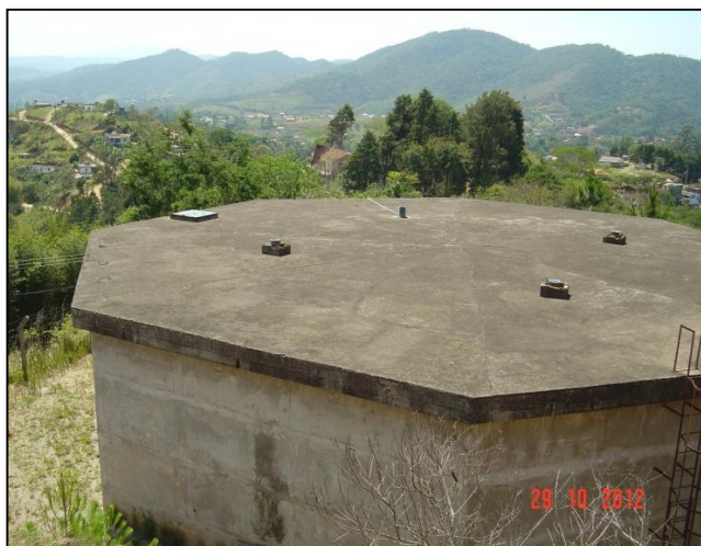
Figura 17 – Reservatório bairro Javary
