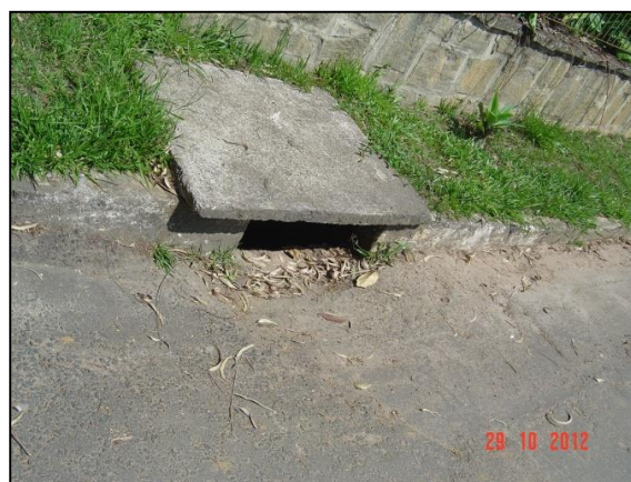
Figura 35 – Boca de lobo 2
