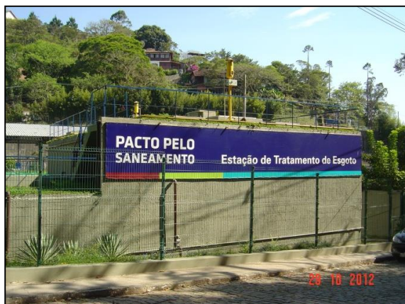
Figura 28 – Placa de identificação da ETE
