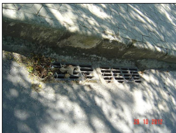
Figura 34 – Boca de lobo 1
