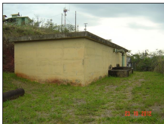
Figura 19 – Reservatório Morro da Caixa 1
