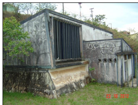
Figura 20 – Reservatório Morro da Caixa 2
