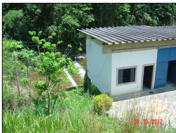
Figura 11 – Estação elevatória de água bruta
