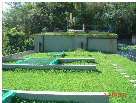
Figura 29 – Vista da ETE Javary 1
