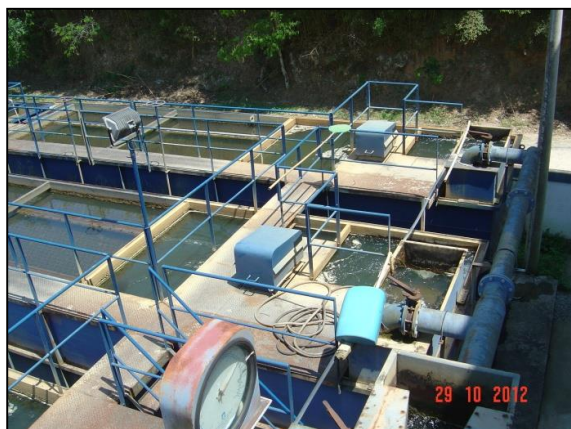
Figura 13 – Vista da ETA Fragoso
