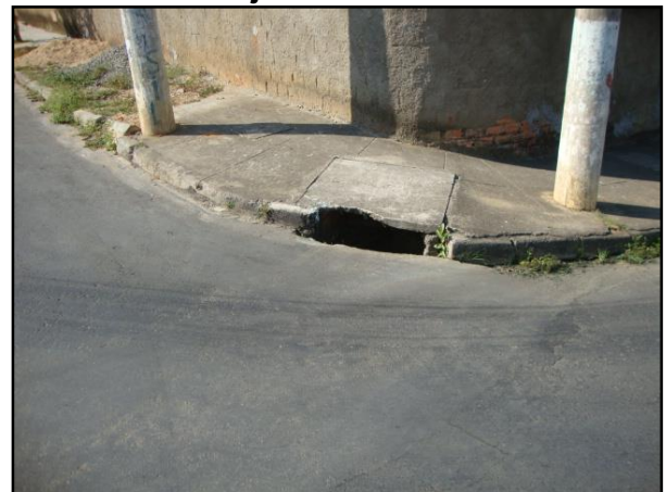
Figura 35 – Boca de lobo danificada e sarjeta obstruída
