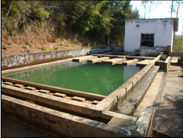
Figura 8 – Vista da ETA Fábrica
