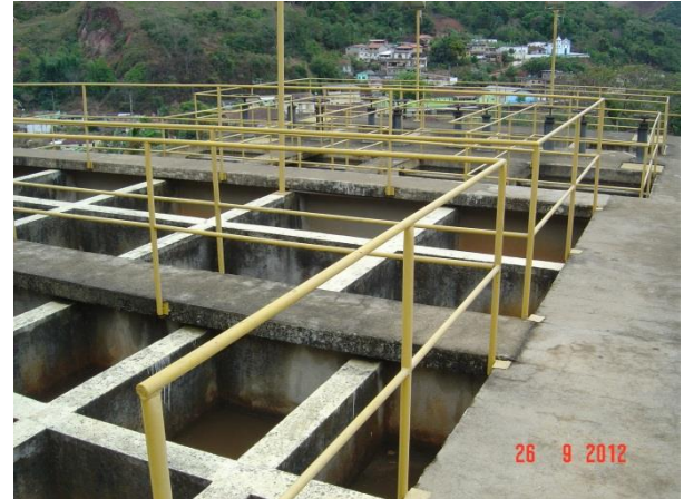
Figura 11 – Vista dos decantadores e filtros
