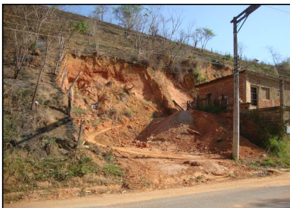
Figura 40 – Erosão de talude
