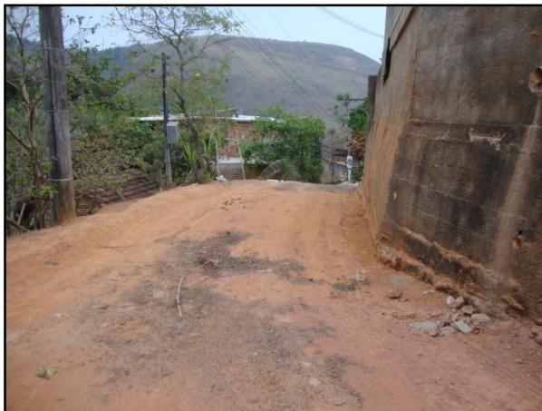
Figura 32 – Rua com carreamento de solo pela falta de drenagem
