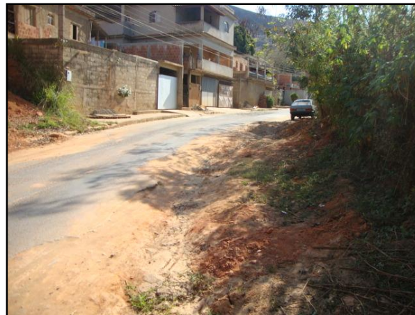
Figura 33 – Erosão e pavimentação comprometida pela falta de drenagem
