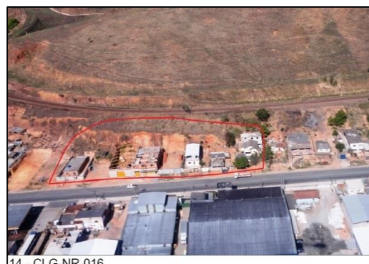
Figura 45 – Área de risco no bairro Retá na Estrada União Indústria
