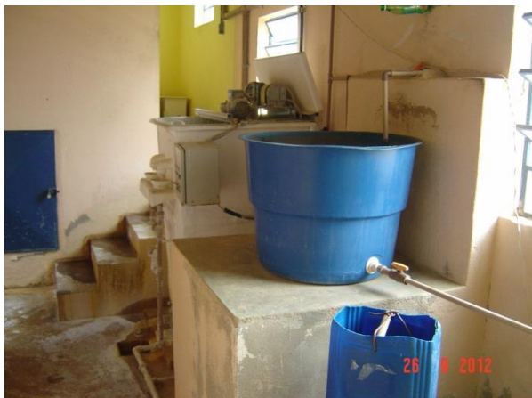
Figura 12 – Vista da casa de química
