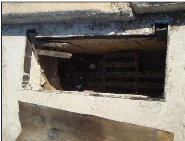
Figura 34 – Boca de lobo apresenta grade danificada
