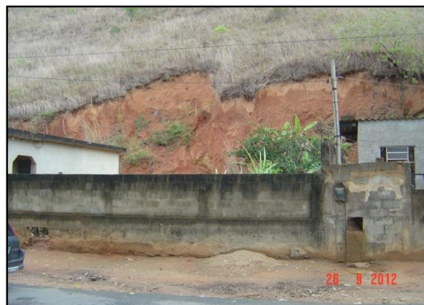
Figura 41 – Erosão de talude
