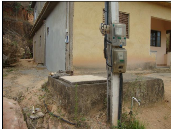
Figura 19 – Detalhe da cisterna – bairro Reta
