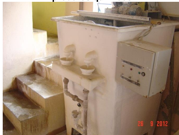
Figura 13 – Sistema de dosagem de produtos químicos
