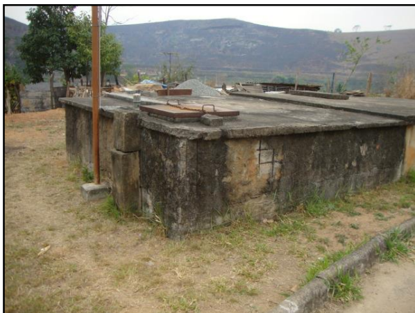
Figura 18 – Vista do Reservatório R02
