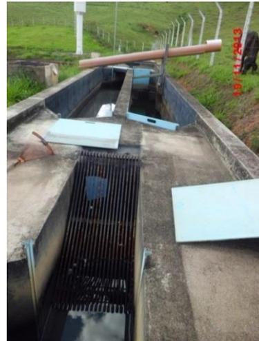
Figura 30: Tratamento preliminar – grelha e desarenador.
