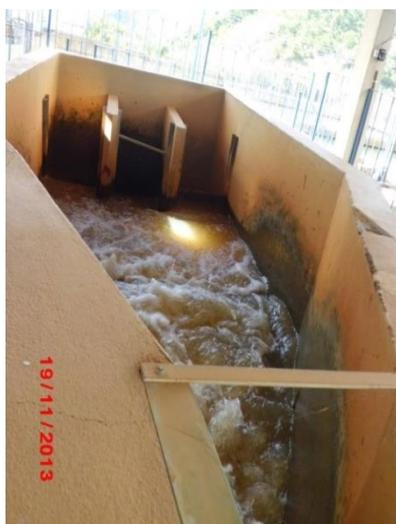
Figura 24: ETA Carangola – medidor de vazão.
