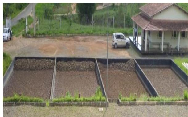
Figura 34: Leito de secagem do lodo.
