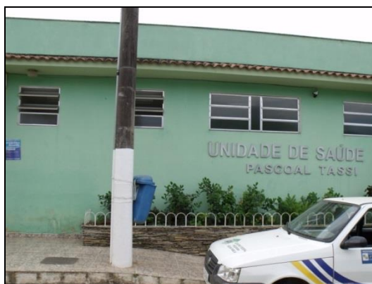
Figura 5 – Fachada da UBS
