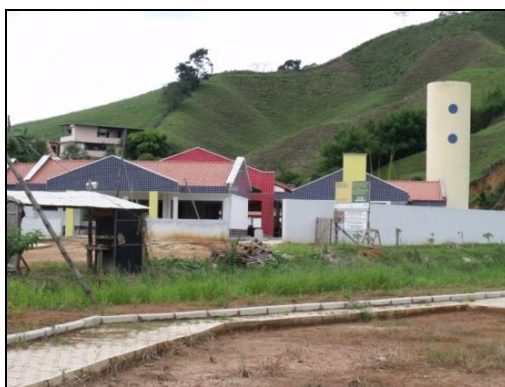
Figura 4 - Creche em construção
