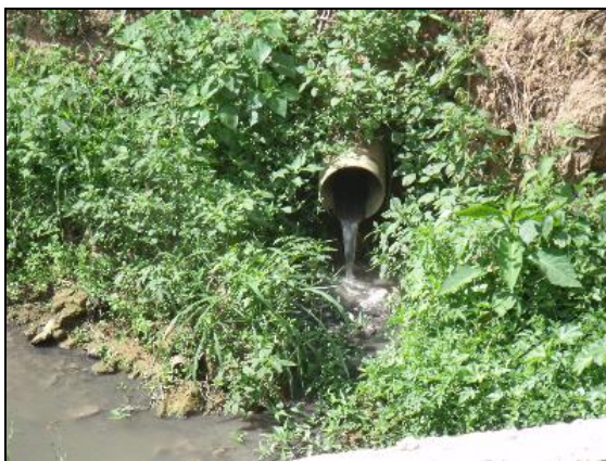
Figura 10 - Esgoto lançado in natura no córrego
