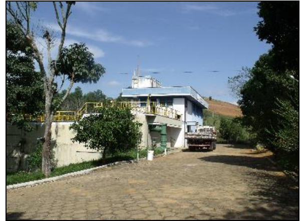
Figura 9 – Estação de tratamento de Água
