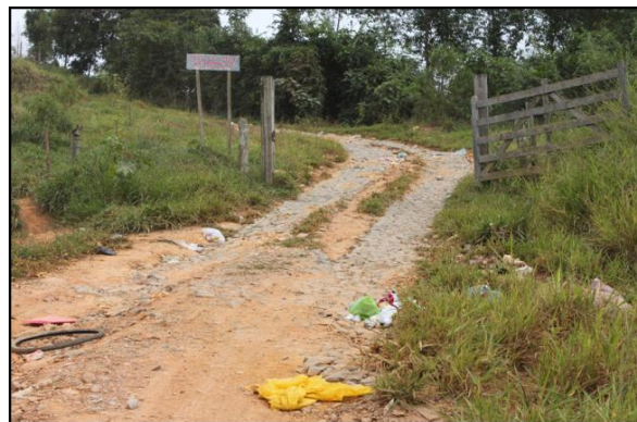
Figura 39– Entrada do Aterro Controlado
