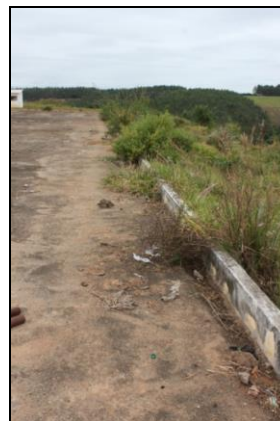
Figura 35 – Canaleta de drenagem de chorume
