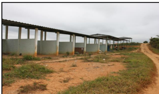
Figura 24 – Vista geral da UTC
