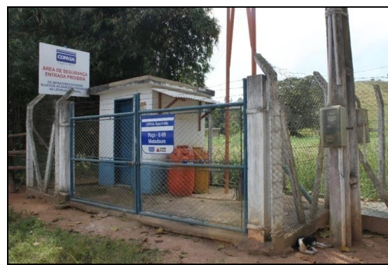
Figura 10 – Poço de captação de água para abastecimento
