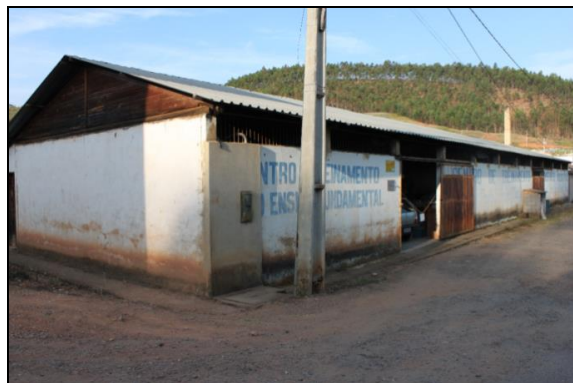
Figura 51 - Fachada da empresa Galpão do Palito
