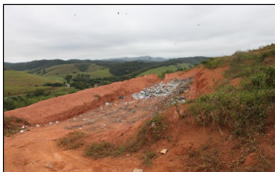
Figura 41 – Vala em uso no aterro controlado
