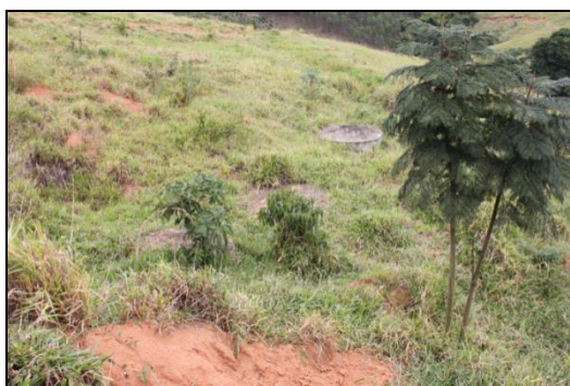
Figura 36 – Estação de tratamento de efluente
