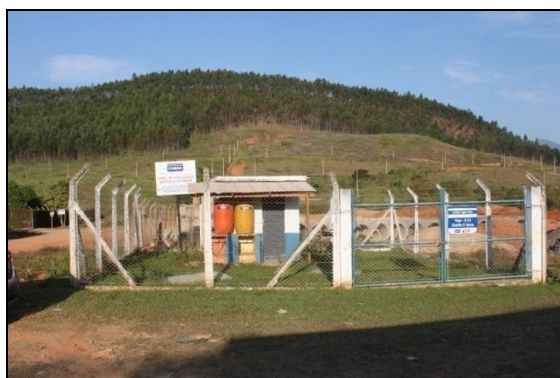
Figura 9 – Poço de captação de água para abastecimento
