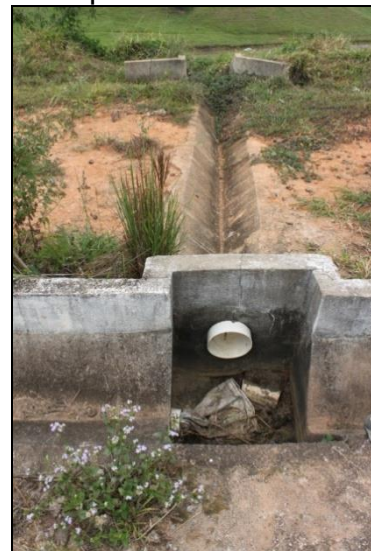
Figura 33 – Canaleta de drenagem de águas pluviais
