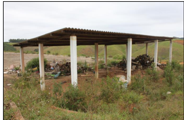
Figura 31 – Área coberta para armazenamento dos resíduos triados e prensados
