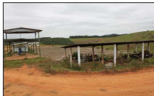
Figura 25 – Vista geral da UTC
