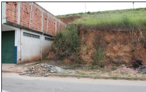
Figura 59 - RCC disposto indevidamente
