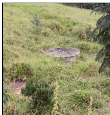
Figura 37 – Estação de tratamento de efluente
