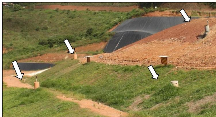
Figura 44 - Drenos de Gases
