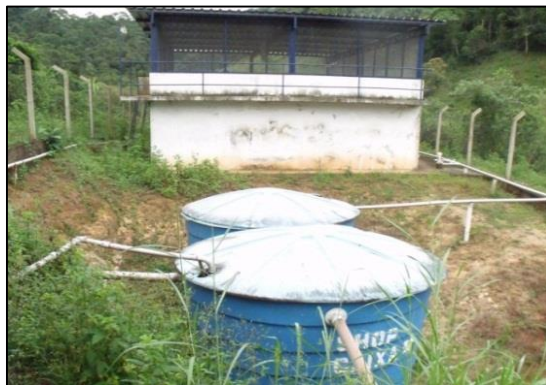
Figura 7 – Ponto de captação de água
