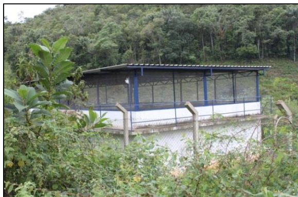
Figura 8 - Área de tratamento da água
