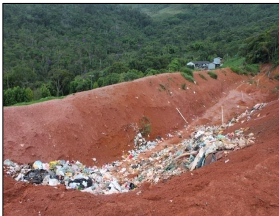
Figura 34 - Aterro Controlado da UTC
