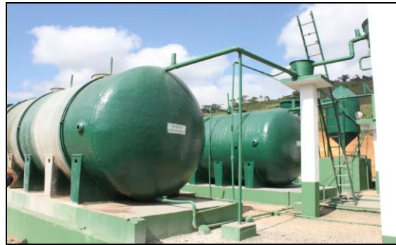
Figura 32 - Estrutura da ETLP
