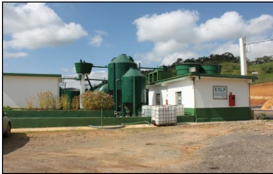
Figura 31 - Entrada da Estação de Tratamento de Líquidos Percolados – ETLP
