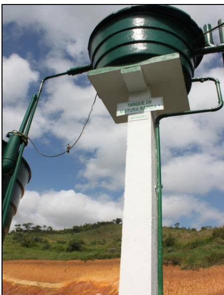
Figura 39 - Tanque de Mistura Rápida
