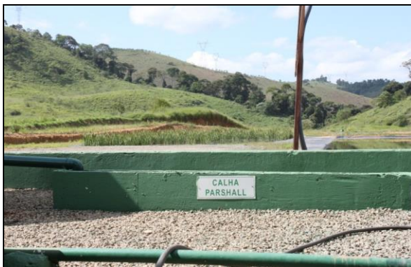
Figura 37 - Calha Parshall
