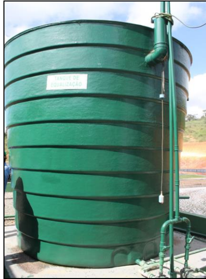
Figura 36 - Tanque de Equalização
