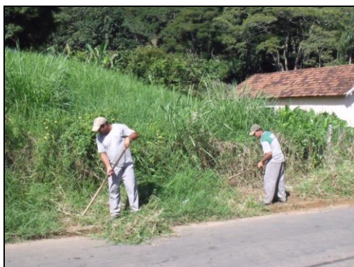
Figura 49 – Funcionários da Prefeitura realizando a capina
