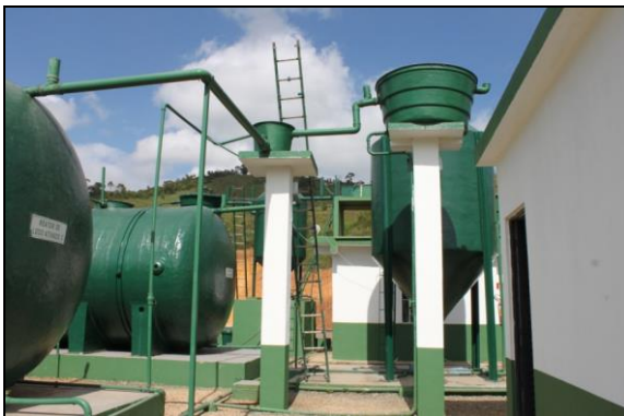
Figura 33 - Estrutura da ETLP
