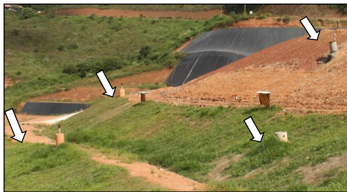
Figura 41 - Drenos de gases
