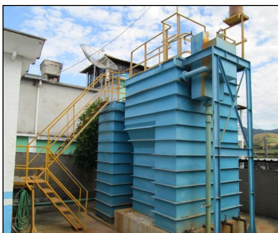
Figura 8 – Estação de Tratamento de Água (ETA) compacta
