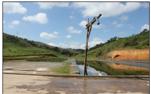
Figura 38 - Líquido utilizado para umidificação de vias
