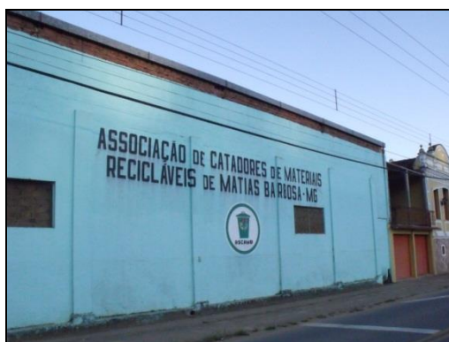
Figura 46 – Galpão da ASCAMB
