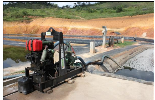
Figura 34 - Tratamento do chorume
