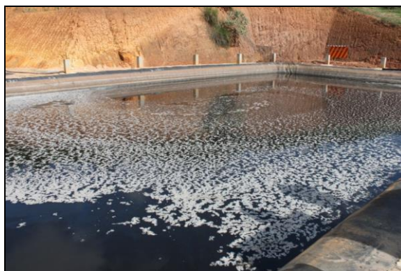
Figura 35 - Piscina de decantação
