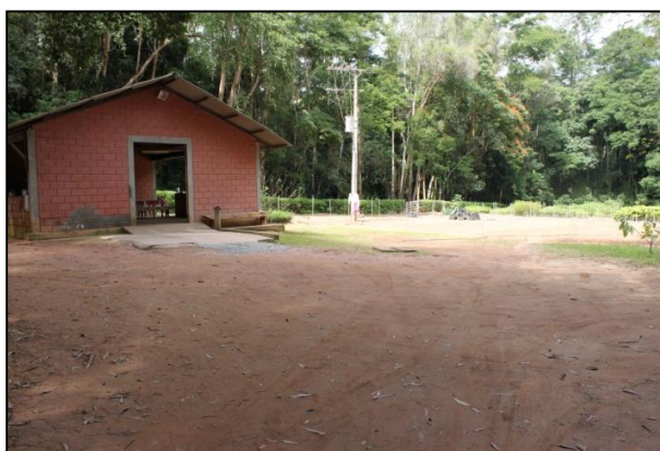
Figura 7 - Estação Ecológica de Mar de Espanha (Horto), local da Oficina
