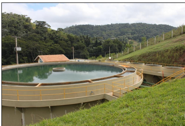
Figura 7 – Estação de Tratamento de Água de Mar de Espanha
