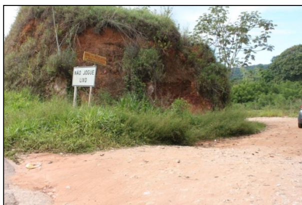
Figura 19 – Acesso à Usina de Triagem e Compostagem
