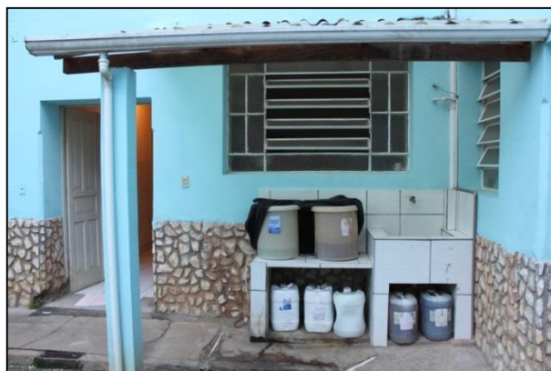
Figura 28 - Local de armazenamento dos resíduos químicos na Santa Casa
