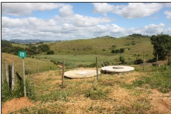
Figura 34 – Sistema de Tratamento do Chorume
