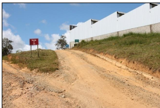
Figura 25 – Acesso à UTC
