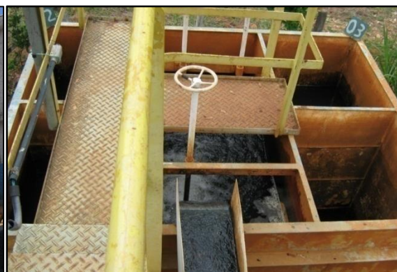
Figura 9 – Vista Superior da ETA
