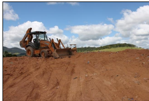
Figura 38 – Máquinas Utilizadas no Aterro Controlado
