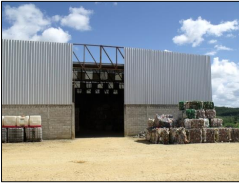
Figura 30 – Vista Externa do Galpão de Armazenamento
