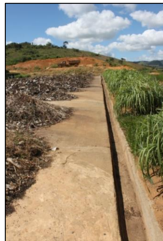
Figura 33 – Vista das Canaletas para
