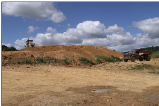
Figura 37 – Vista do Aterro Controlado
