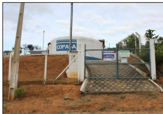
Figura 8 – Vista da ETA
