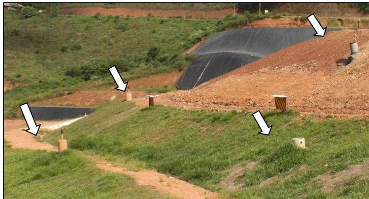
Figura 38 - Drenos de gases
