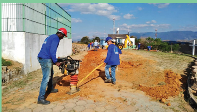
Início da obra em Areias
