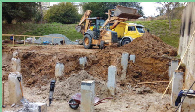
Remoção de solo para execução de laje em Jacareí
