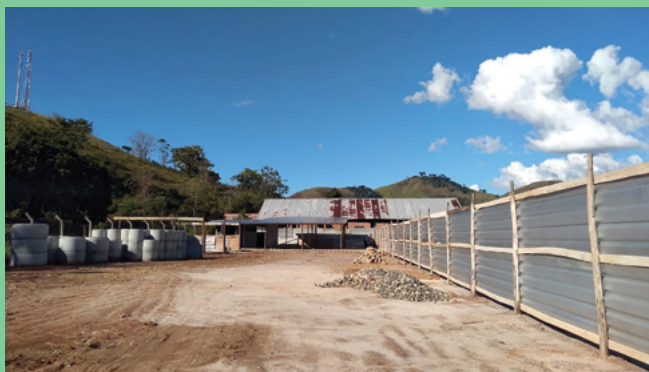
Canteiro de obras em São José do Barreiro
